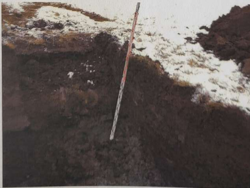
Abb. 18: Baggerschurf 3 (BS3) Schurfgrube
