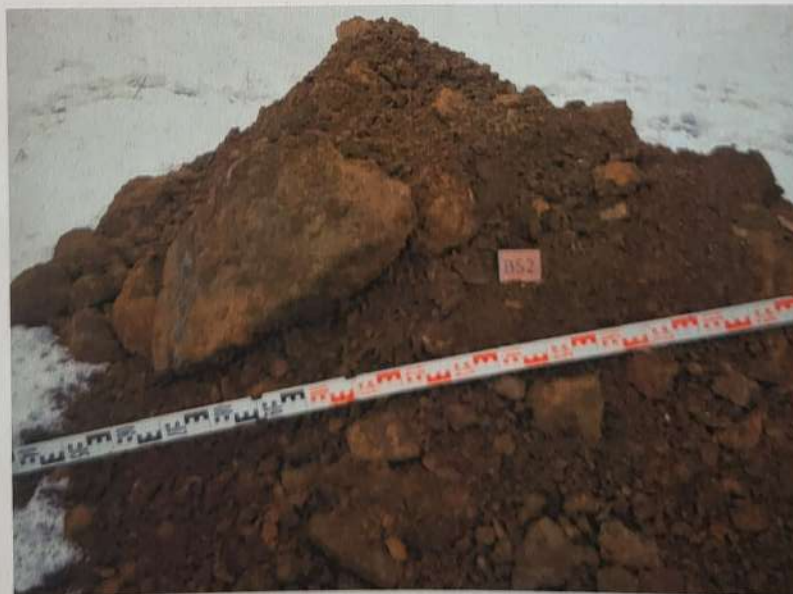
Abb. 16: Baggerstich 2 (BS2) Auswurf: Schluff-Kies-Gemisch, steinig, blockig
