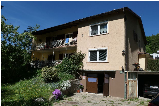
Wohnhaus, Ansicht von Südosten
