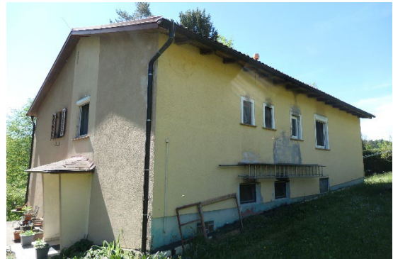
Wohnhaus, Ansicht von Norden
