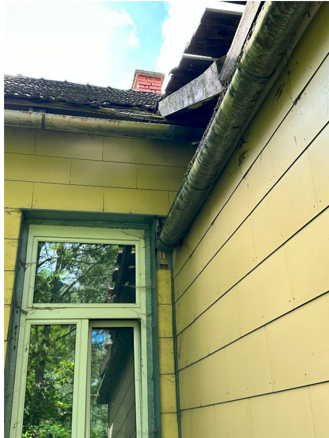
Foto 33: Fenster und Dach
