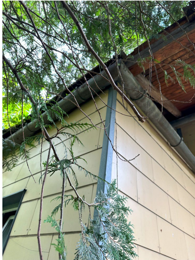
Foto 35: Fassade und Dach
