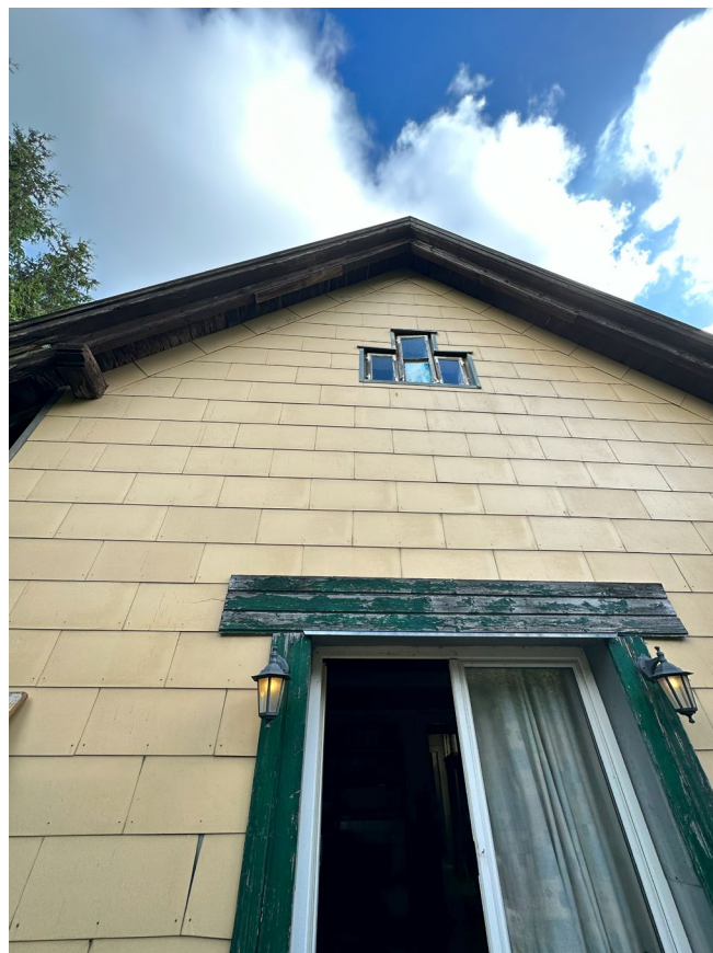
Foto 31: Blick auf das Dach
