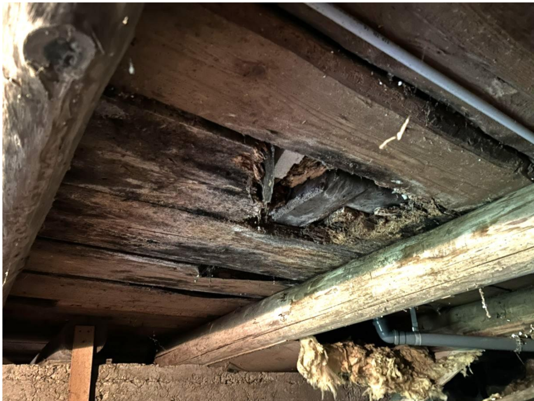
Bild 10: schadhafte Kellerdecke
