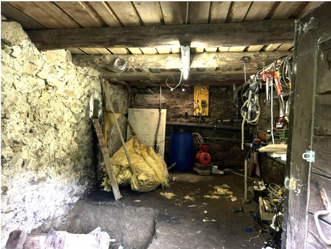
Bild 8: Keller (links eine Grabung damit das eindringende Hangwasser abfließen kann)
