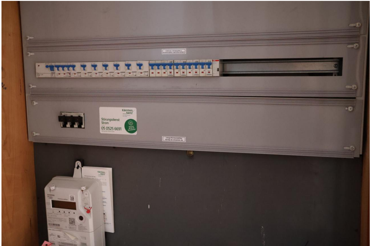
Bild 19 E-Verteiler
