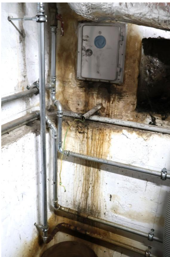
Bild 38 KG Kamin mit Rauchrohranschluss vom Heizkessel
