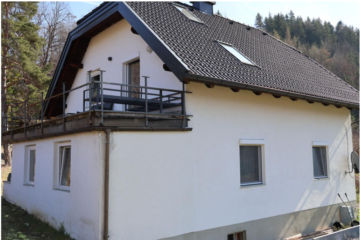
Bild 2 Gebäudeansicht Südwestseite mit angebautem Windfang (WF)
