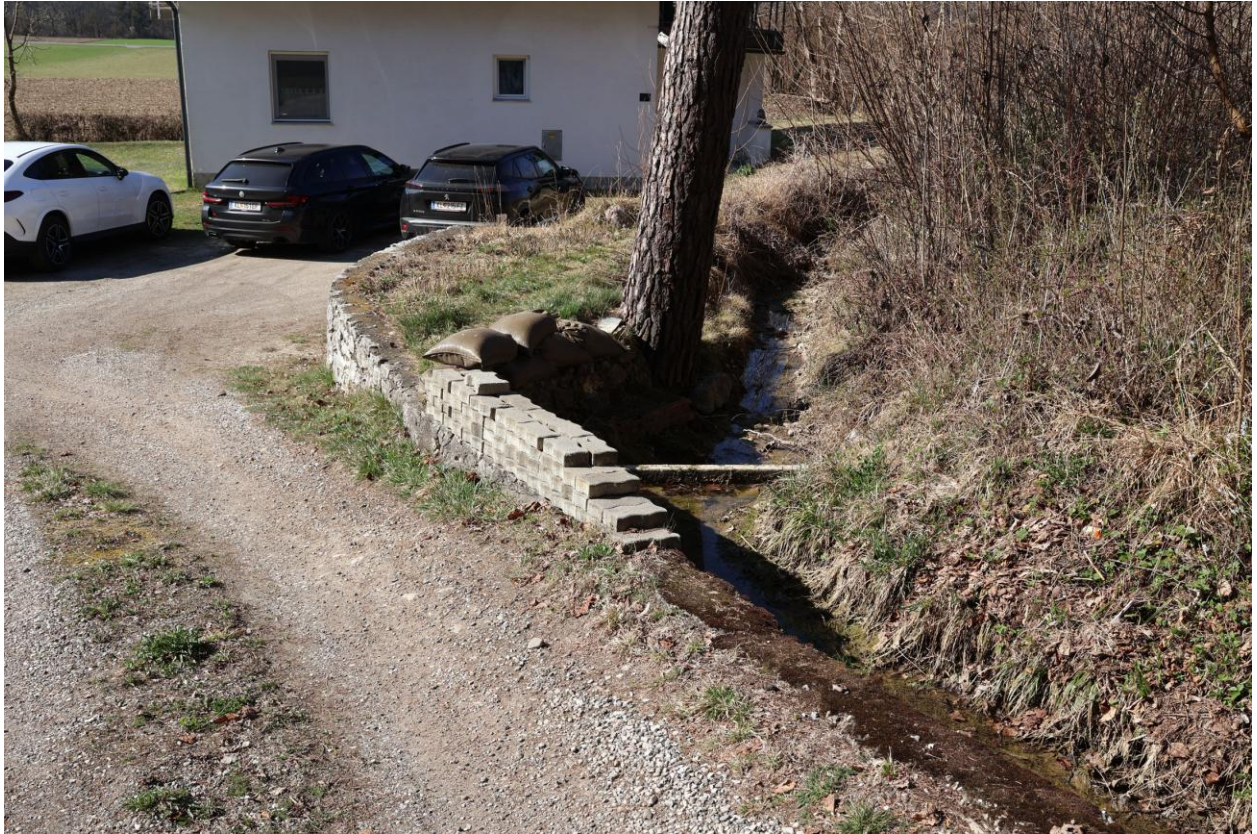
Bild 41 Grundstückszufahrt mit angrenzendem Bachverlauf
