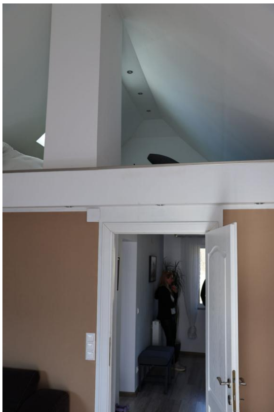
Bild 21 DG Ausbau mit offenem Spitzboden
