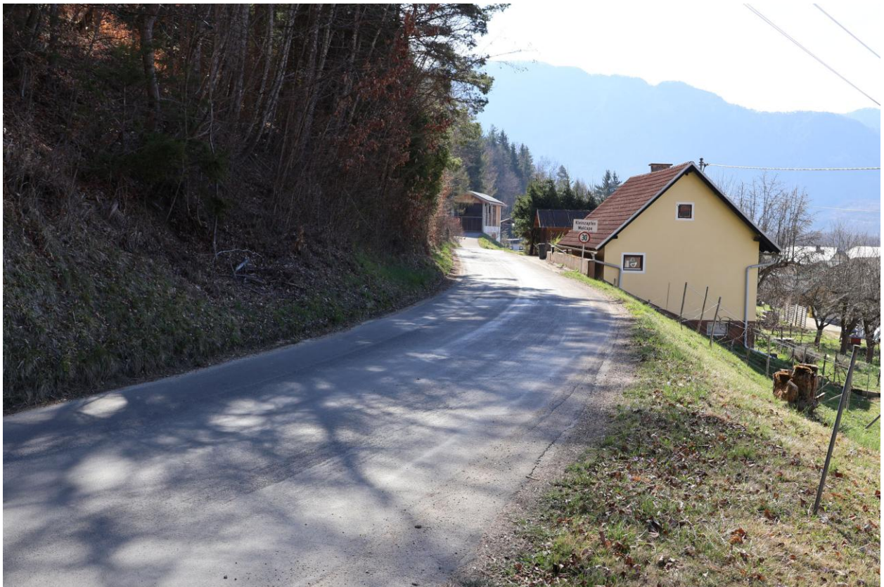
Bild 46 Gemeindestraße Kleinzapfen – Blickrichtung Südost
