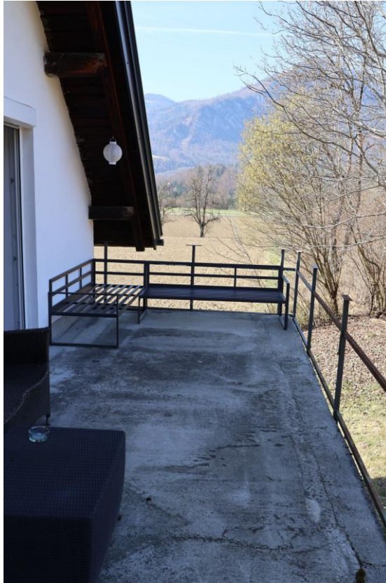
Bild 29 Balkon Ostseite als Flachdach über WF-Zubau
