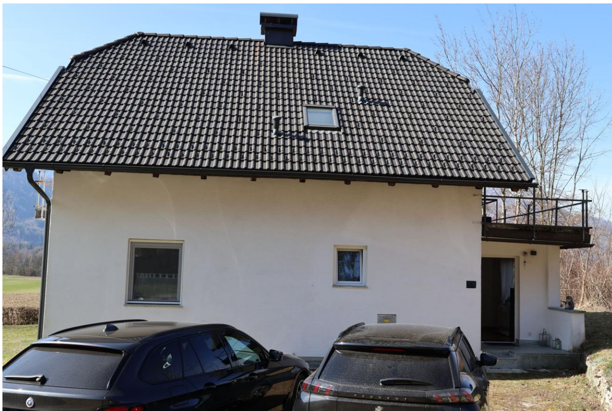
Bild 7 Gebäudeansicht Nordseite mit Hauszugang und Dachflächenfenster vom DG-Bad
