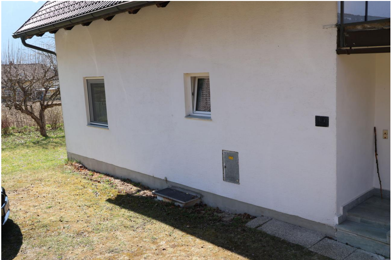
Bild 5 Nordfassade mit Kelag-Anschlusskasten
