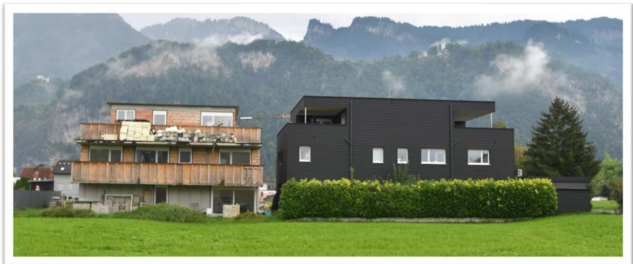
Westansicht, Haus A rechts, Haus B links
