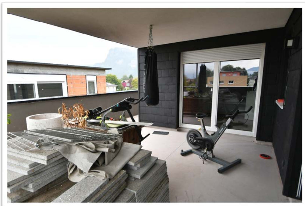
Terrasse Nord: Bodenbelag: Folienabdeckung ohne Bodenbelag (der Bodenbelag ist auf der Terrasse gelagert)
