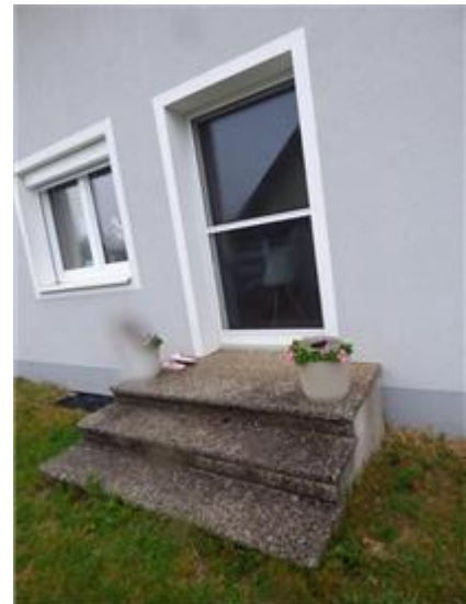
Zugang zur Küche von außen
