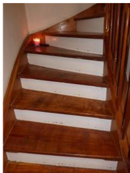
Stiegenaufgang ins Dachgeschoss
