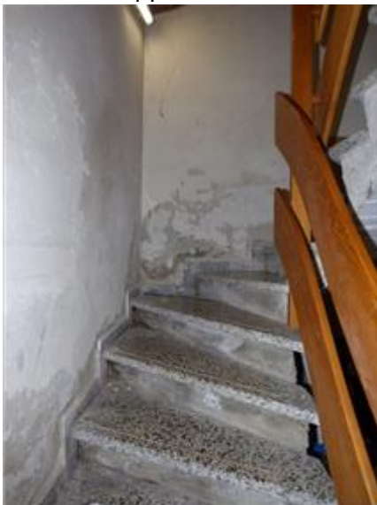
Stiegenabgang ins Kellergeschoss
