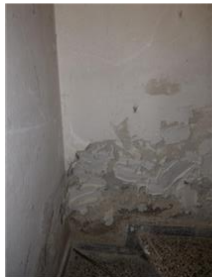
Feuchte-/Putzschäden
