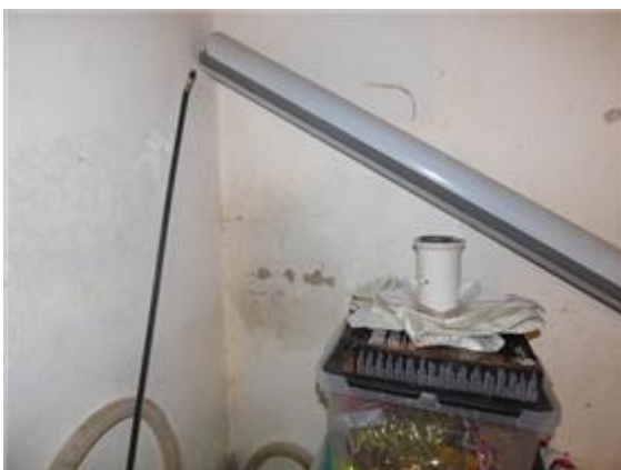
Feuchteschäden / Putzabblätterungen
