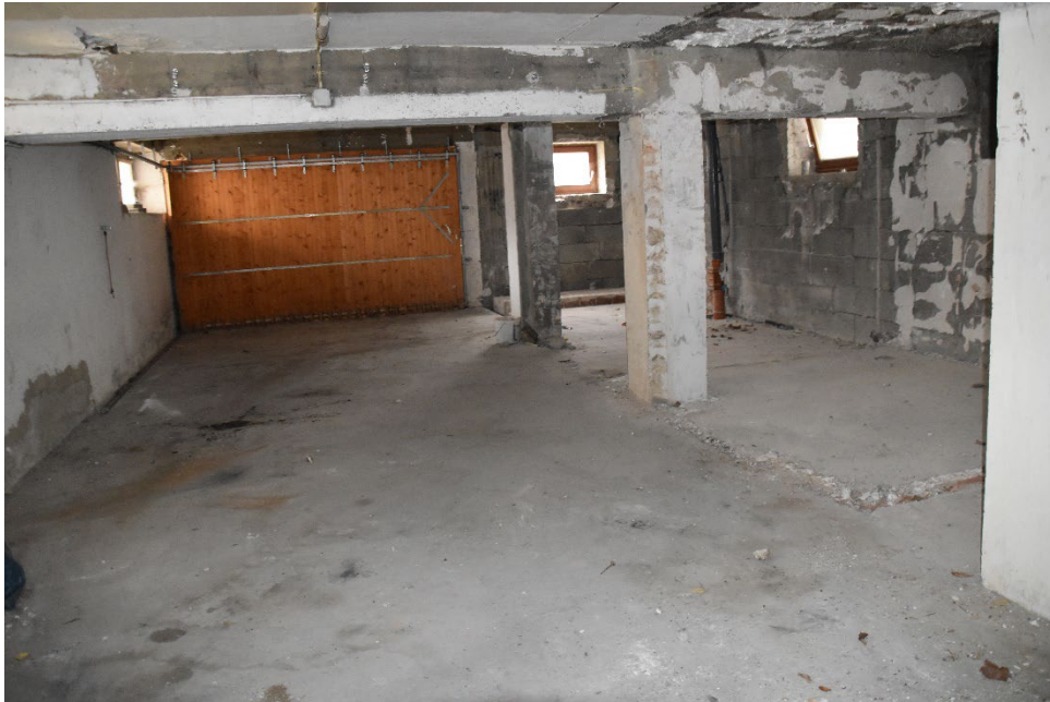
Großkeller Zubau West
