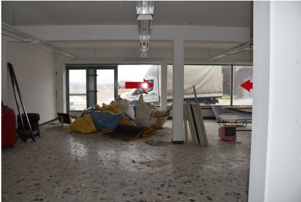
ehemaliges Geschäft Zubau Süd
