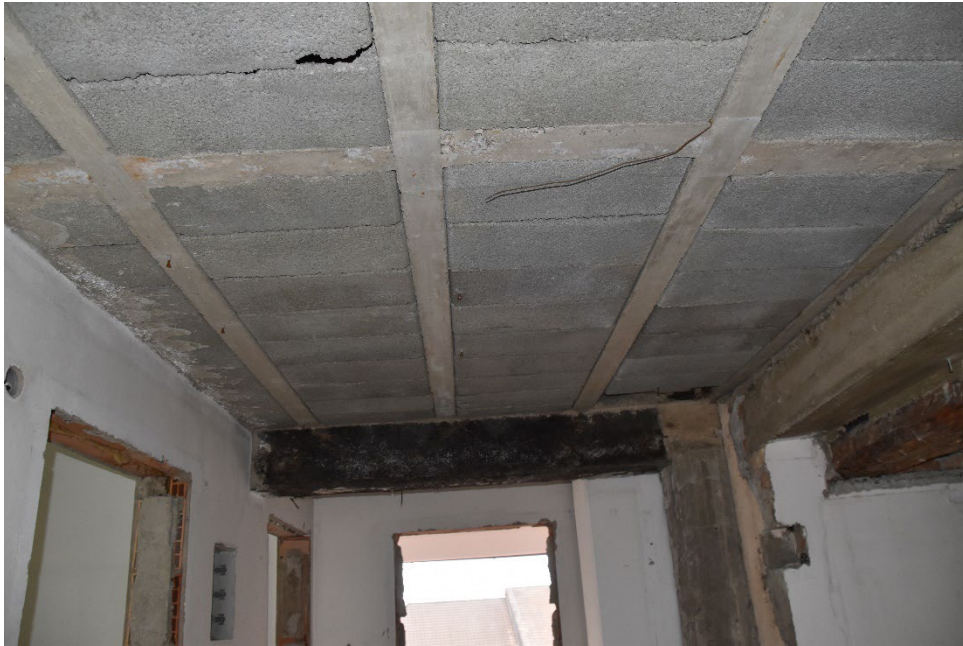
obere Geschosse – Zubau Süd
