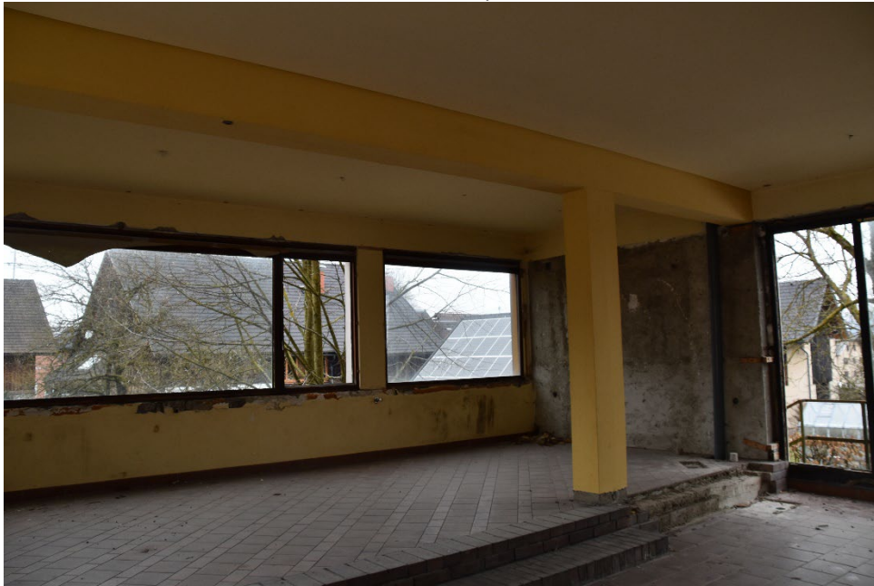
Übergang Altteil – Zubau West
