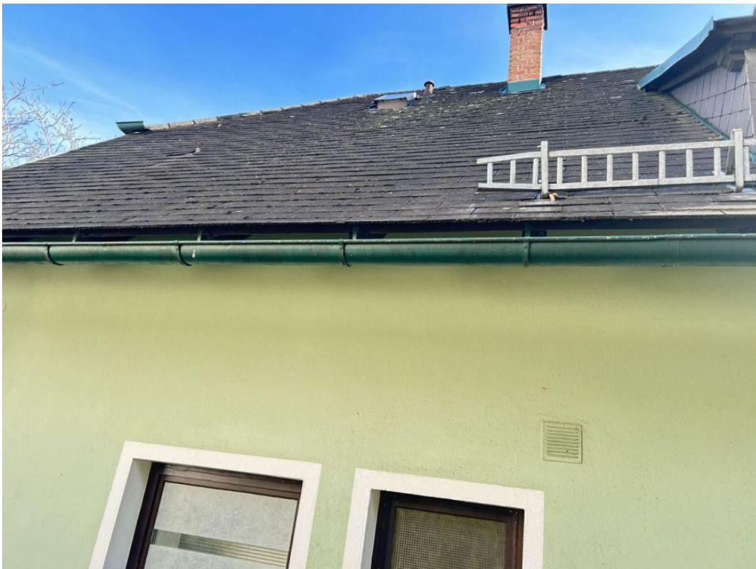
Bild 8: Dacheindeckung und Rinnen
