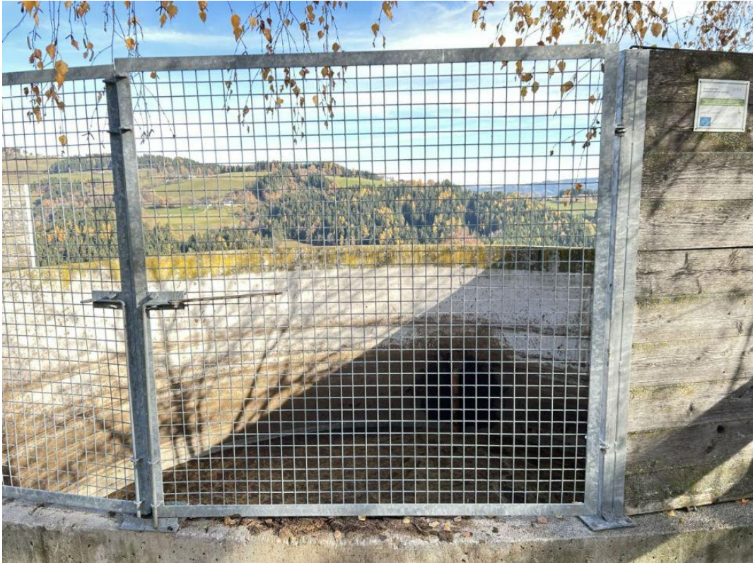
Bild 23: Güllegrube ohne Decke
