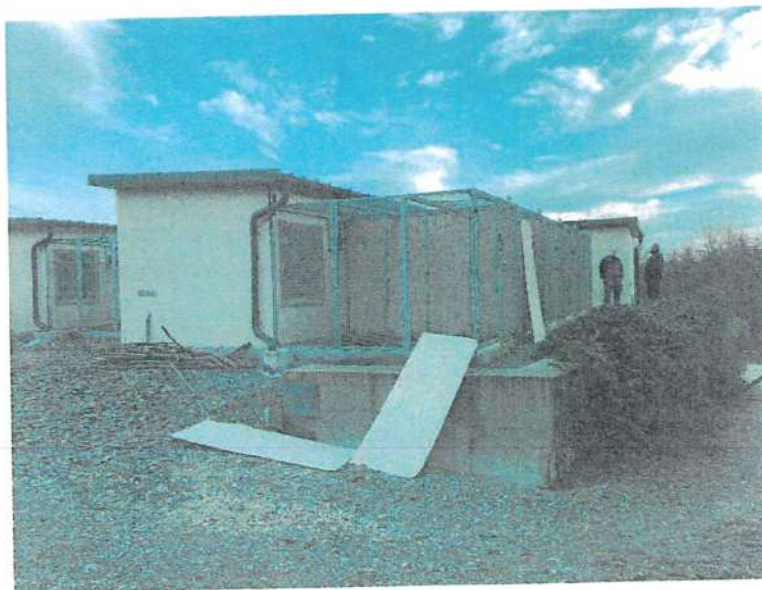
Abb. 11: Gebäudeteil 5, Ansicht Süd mit Stützmauer
