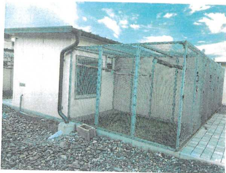
Abb. 12: Gebäudeteil 4, Ansicht Süd
