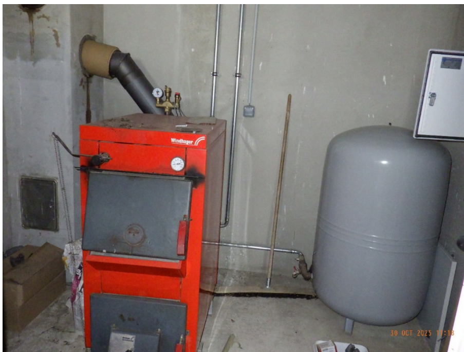
Hackschnitzelheizung und Stückgutkessel sowie Boiler
