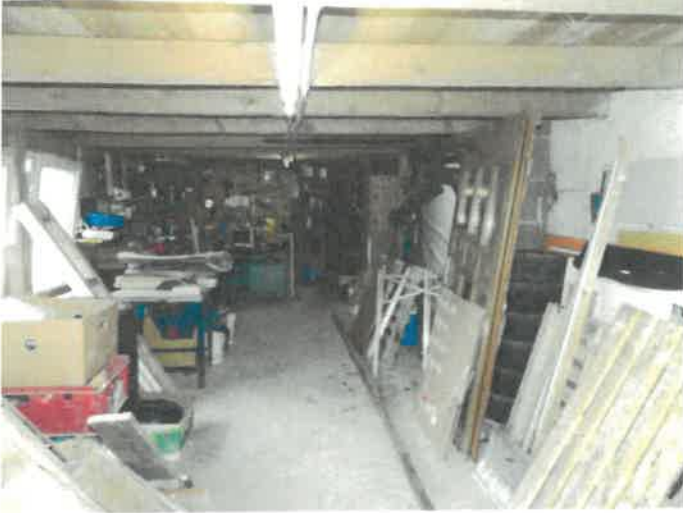
Lagerraum mit Holztramdecke in der Scheune
