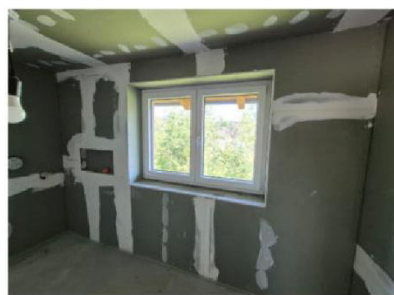
Bad mit GK-Platten für Nassbereich, malerfertig gespachtelt, wie gesamte Sanitärausstattung, Boden- und Wandbeläge
