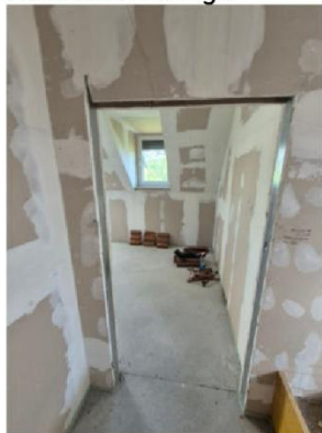
Zugang zu Schlafzimmer Ost: Türsturz zu niedrig, Wände und Schrägen malerfertig gespachtelt, Komplettierung Elektro noch ausständig wie auch noch keine Bodenbeläge
