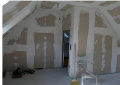
Bad mit GK-Platten für Nassbereich, malerfertig gespachtelt, wie gesamte Sanitärausstattung, Boden- und Wandbeläge
