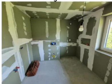
Bad mit GK-Platten für Nassbereich, malerfertig gespachtelt, wie gesamte Sanitärausstattung, Boden- und Wandbeläge
