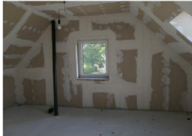
Bad mit GK-Platten für Nassbereich, malerfertig gespachtelt, wie gesamte Sanitärausstattung, Boden- und Wandbeläge
