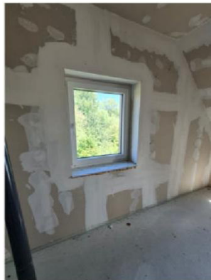
Zugang zu Schlafzimmer Ost: Türsturz zu niedrig, Wände und Schrägen malerfertig gespachtelt, Komplettierung Elektro noch ausständig wie auch noch keine Bodenbeläge
