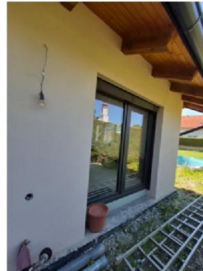
Fenster und Terrassentür im Osten bei nördlichen Queranbau Unfertige Anschlüsse zum Erdreich/Traufe
