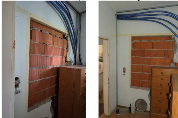
Vorraum zur WI-Küche - unverputzte Ausmauerungen
