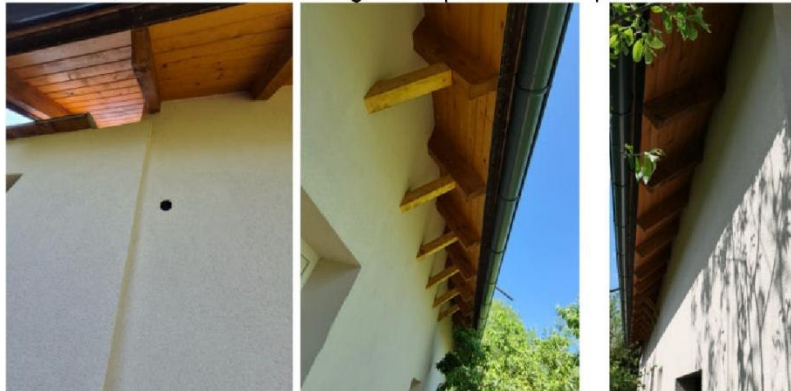
Dachanschluss, zum Teil mit Abstreibungen der Sparren bei Gaupenteil
