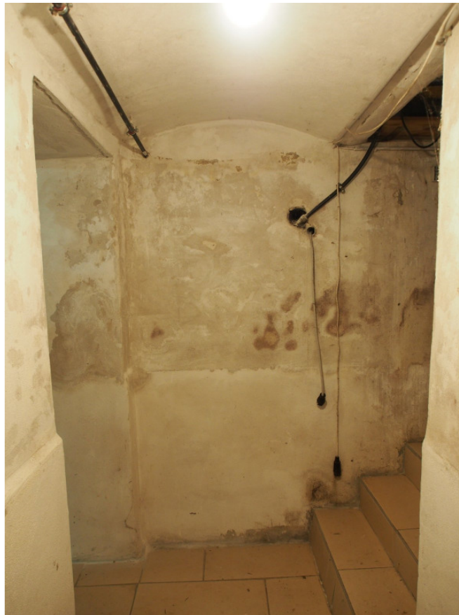
Foto 8 Vorraum samt Stiege
