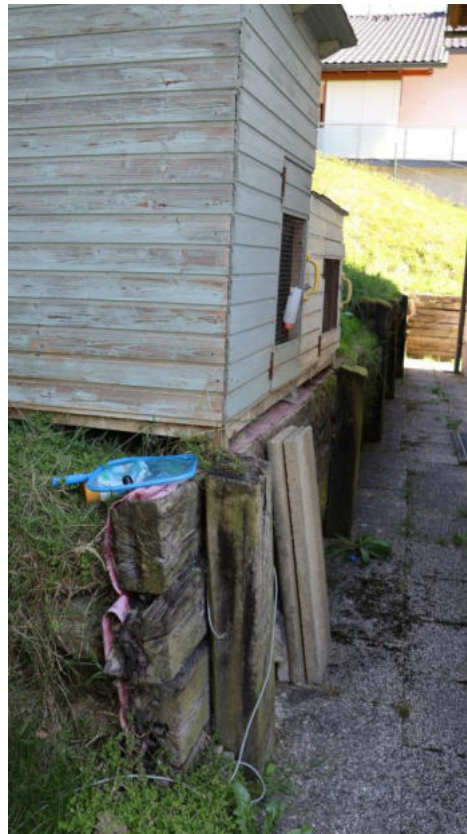
Traufenpflaster mit Holzstützwand an der Nordseite vom Wohnhaus
