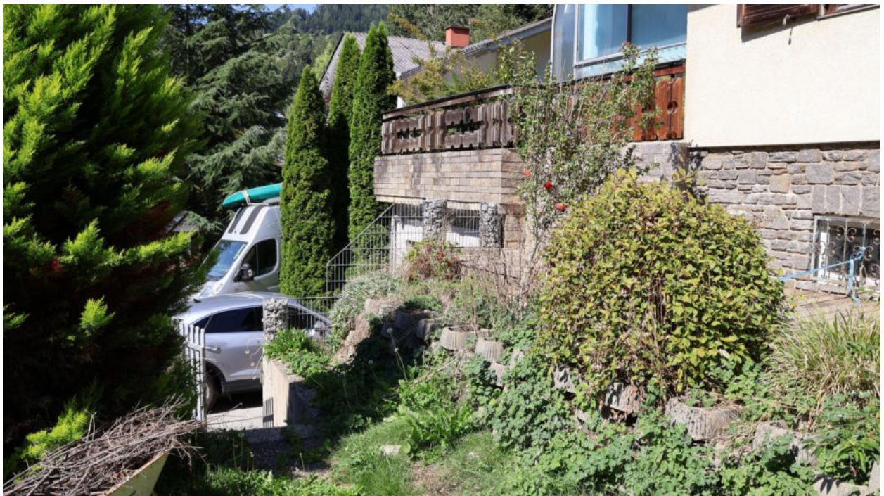
Gartenanlage Südseite mit Hangbefestigung aus Löffelsteinen
