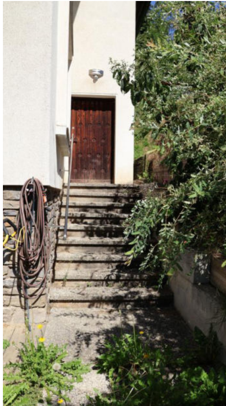
Hauszugang mit Außentreppe
