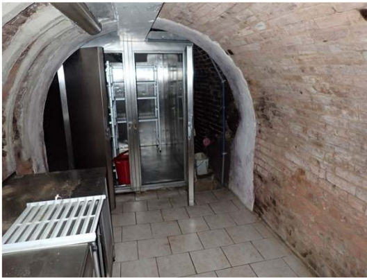
Gewölbekeller mit eingebauter Kühlzelle
