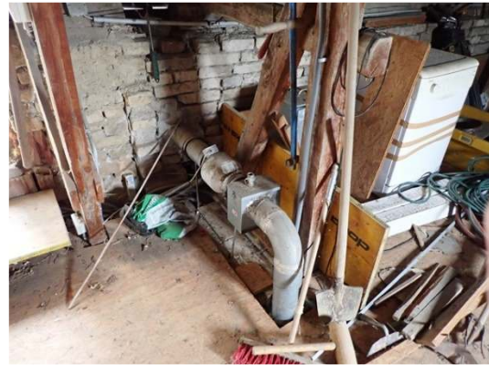
Dachraum mit Entlüftungssträngen
