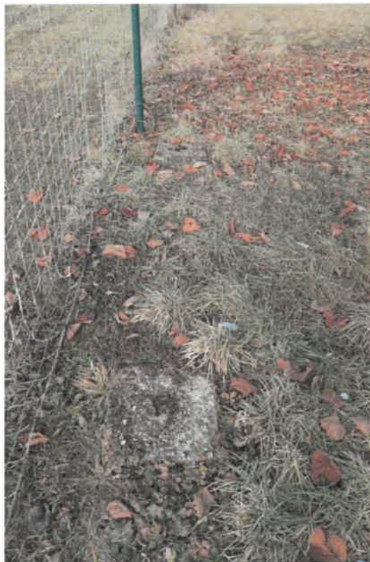
Alte Beton-Einzelfundamente vom alten Ballfangzaun entlang der Westseite
