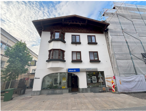
Gebäude von Norden
