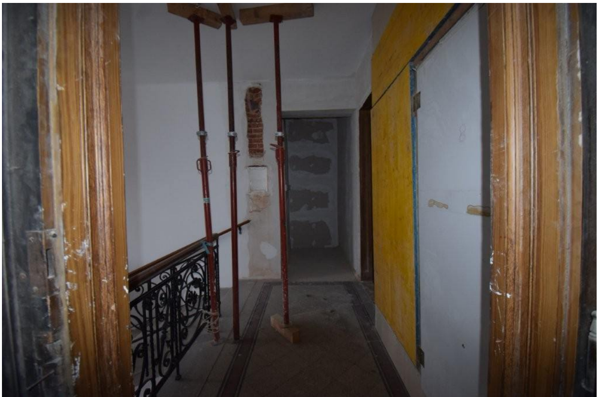
Stiegenhaus vor Top 6
