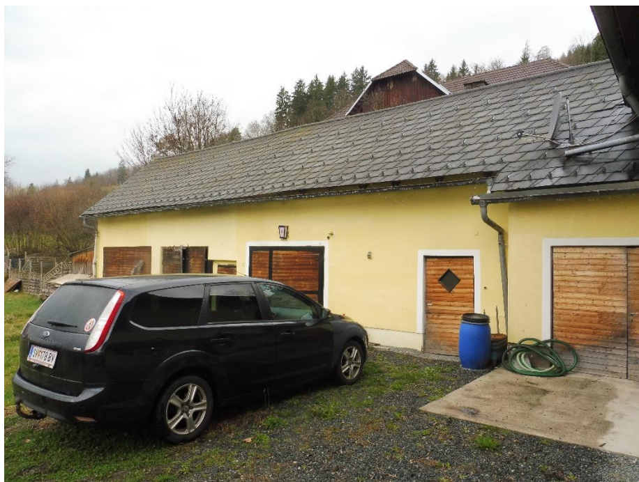
Wirtschaftsgebäude – Ostseite (unten)
