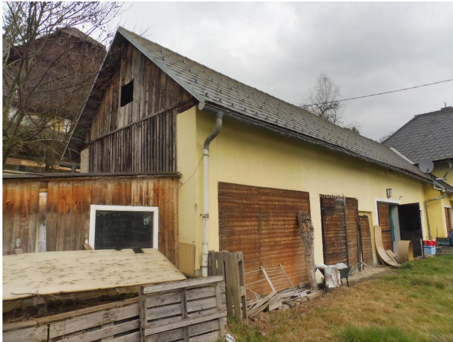
Wirtschaftsgebäude – Süd- und Ostseite
