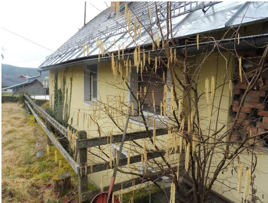
Wohnhaus – Nordseite (oben) und Nord- und Ostseite (unten)
