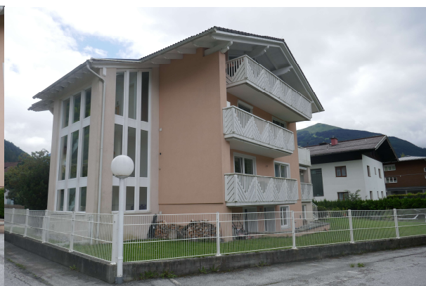
Ansicht von Norden mit Treppenhausenbau und dem Balkon der Wohnung Top W3 im Dachgeschoss
