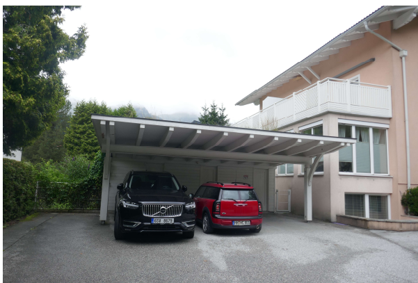
Ansicht von Südosten mit Carport , der mittlere Carport ist Top P3
