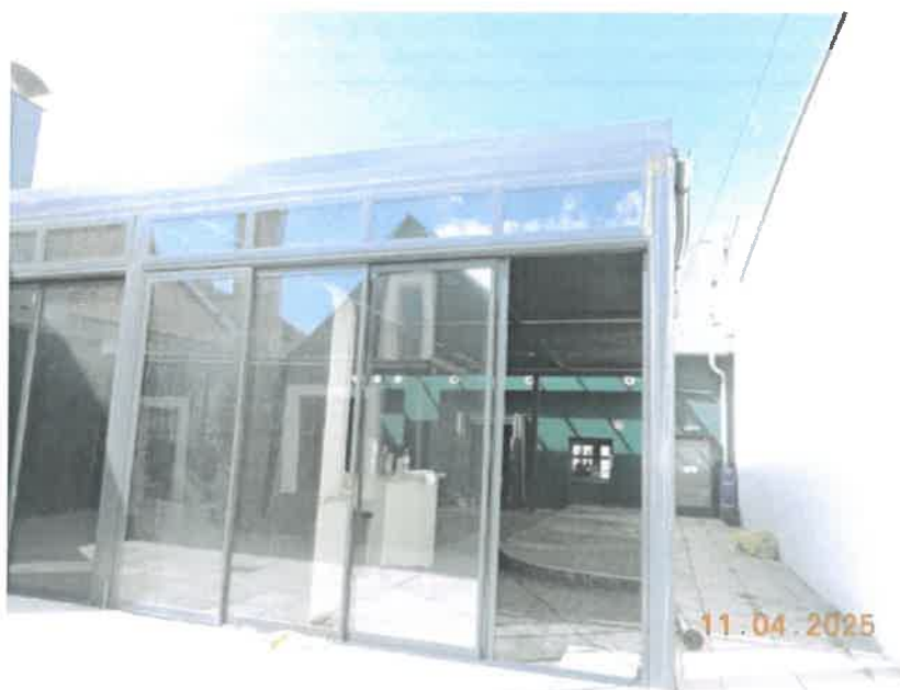
Wintergarten (Nutzung untersagt)
