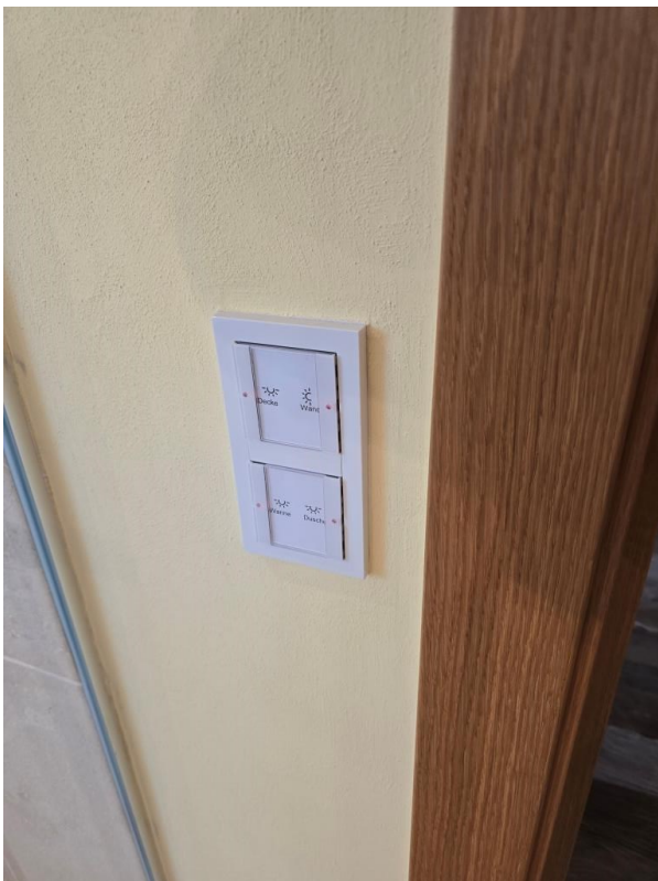
Schalter für Steuerung von Licht und Jalousien
