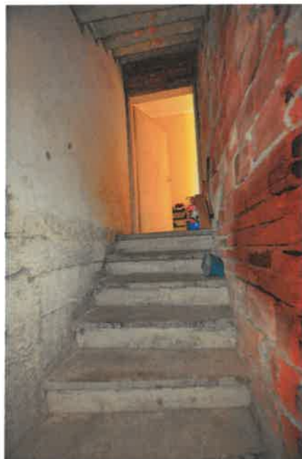
Kellerabgang Heizkeller / Neubau
