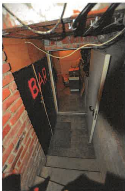
Kellerabgang Heizkeller / Neubau
