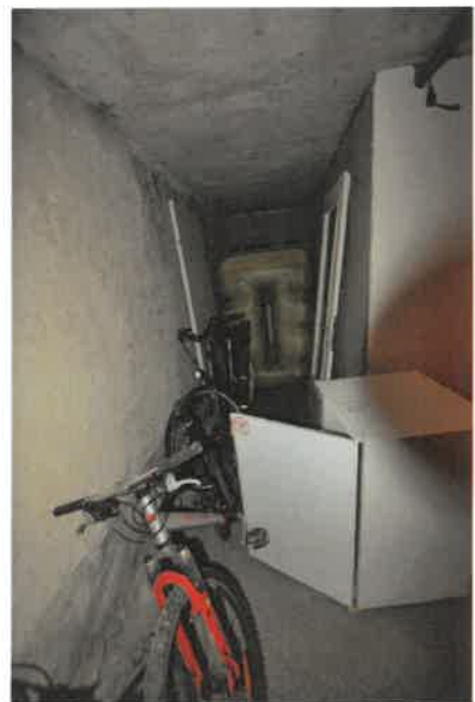
Heizkeller / Neubau / Lager
