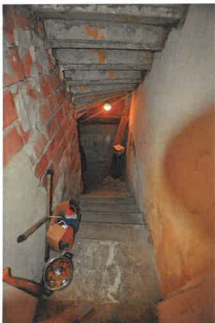
Kellerabgang Heizkeller / Neubau
