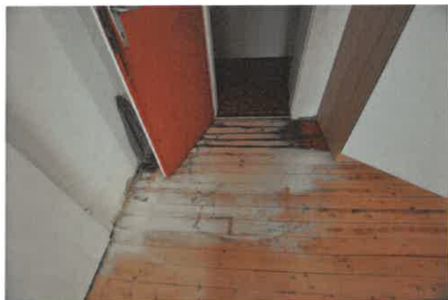
Wohnung W5 / Fußboden
