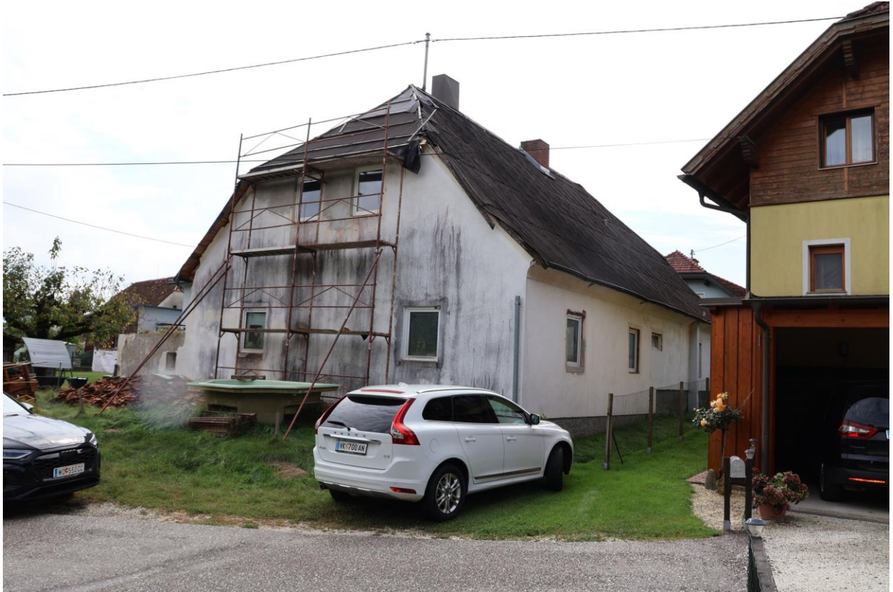
Kelag Stromleitung mit Dachständer am Hausfirst
