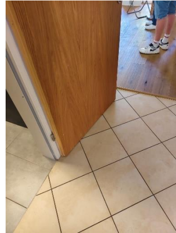
Abbildung 40: Bodenbeläge Flur, Bad, Zimmer
