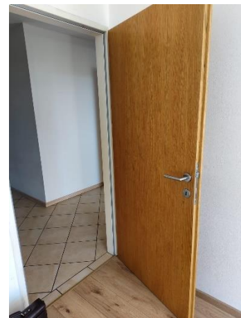
Abbildung 42: Übergang Zimmer zum Flur
