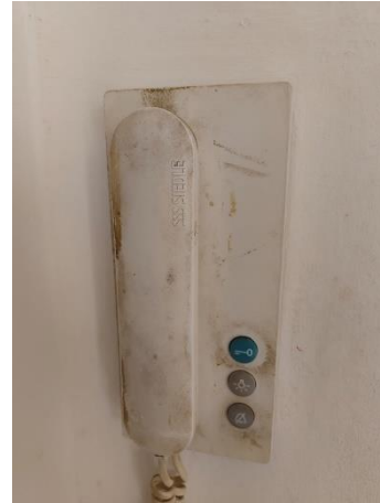
Abbildung 34: Verdrehte Gegensprechanlage
