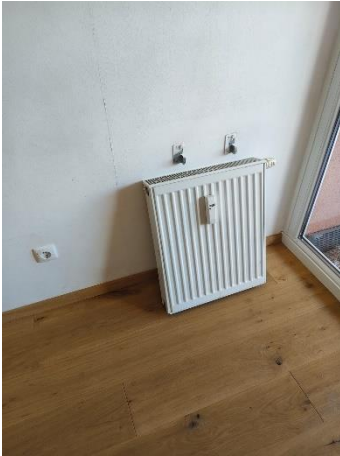
Abbildung 33: Bsp. demontierter Heizkörper
