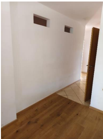
Abbildung 41: Nachträglich eingebaute Zwischenwand im Flur zur Abtrennung eines Zimmers
