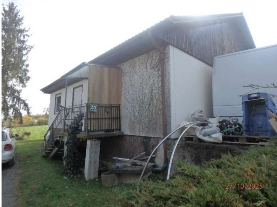
Ansichten vom Wohngebäude
