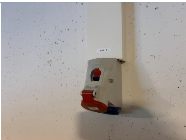
Abbildung 55: Kraftsteckdose / Top W03
