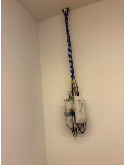
Abbildung 57: Eingangsbereich Top W03
