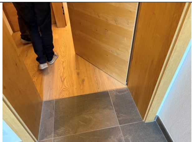
Abbildung 56: Eingangsbereich Top W03
