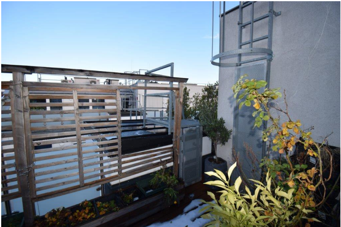
W 19/ Terrasse 2. Dachgeschoß
