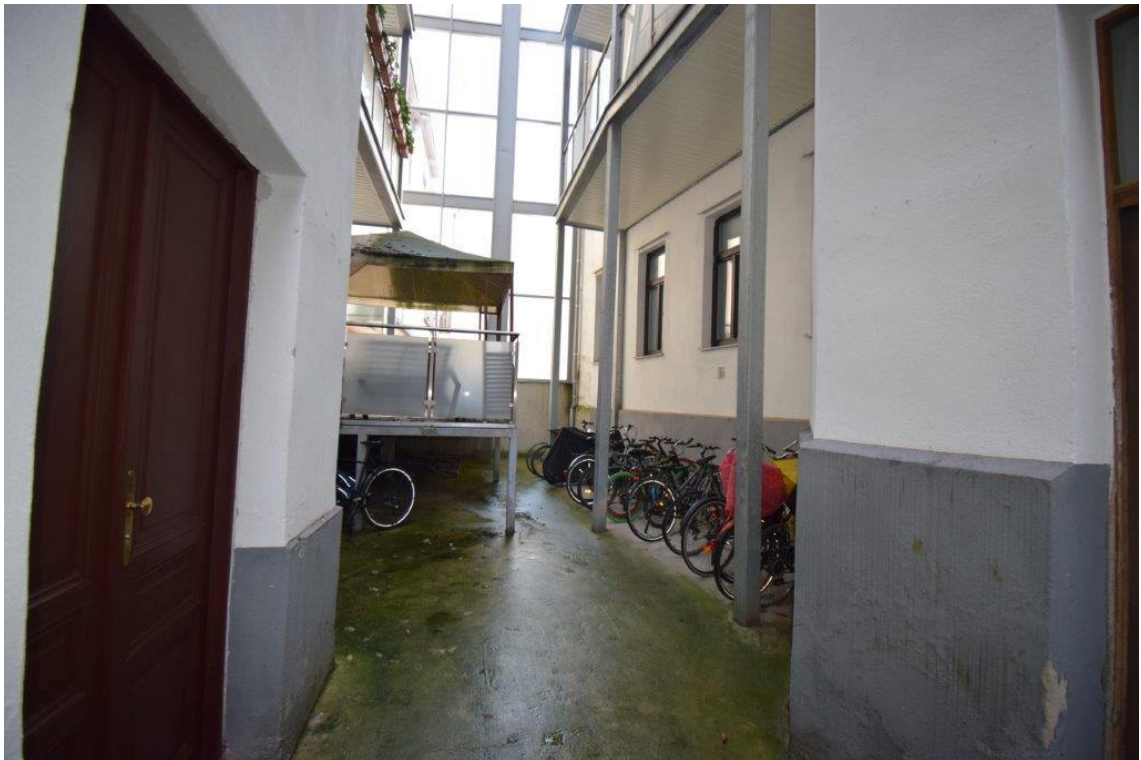
Innenhof Fahrradabstellplatz / Stellplatz 3
