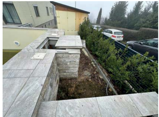
Bild 14 - Pool und Stützmauer Pool
