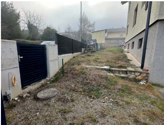
Bild 25 – Zaun straßenseitige Grundstücksgrenze
