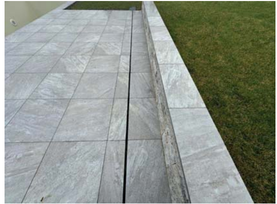
Bild 12 – Terrasse bei Pool
