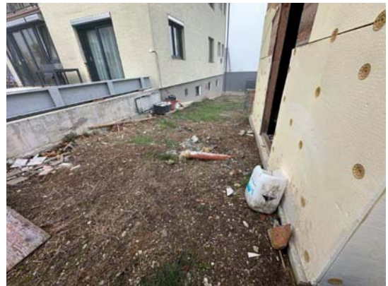
Bild 20 – rechts im Bild Gerätehütte
