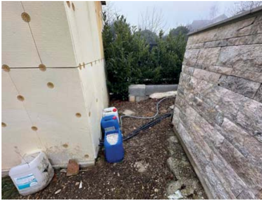
Bild 17 – Stützmauer Pool und Gerätehütte
