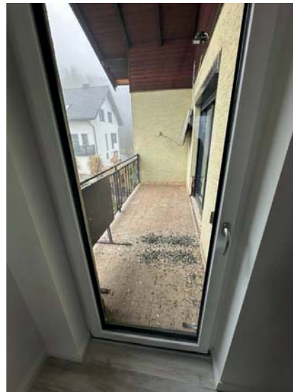
Bild 70 – Zugang zu Balkon
