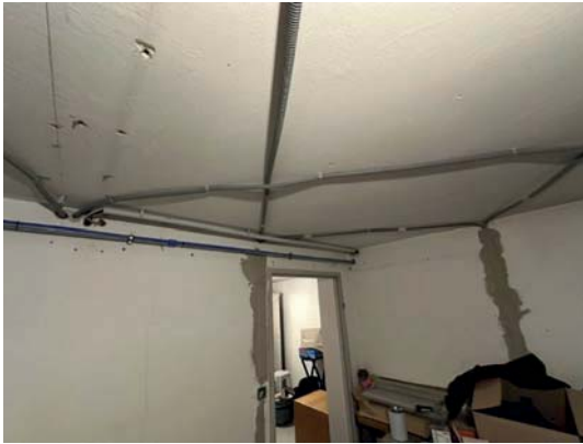
Bild 35 – Kellerraum von Bild 31
