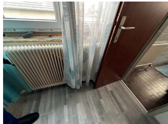
Bild 46 -alter Radiator und Zugang WC
