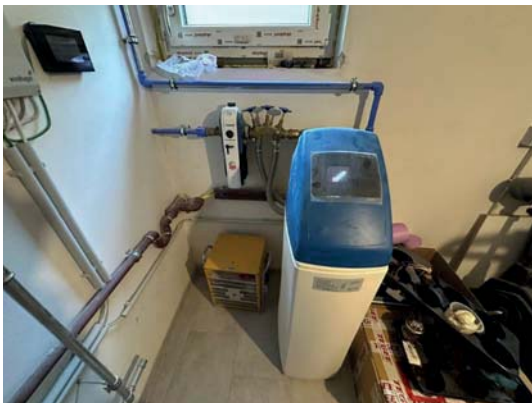
Bild 39 – Wasseraufbereitungsanlage
