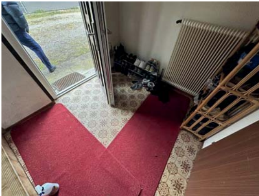
Bild 29 – Vorraum mit altem Gliederheizkörper
