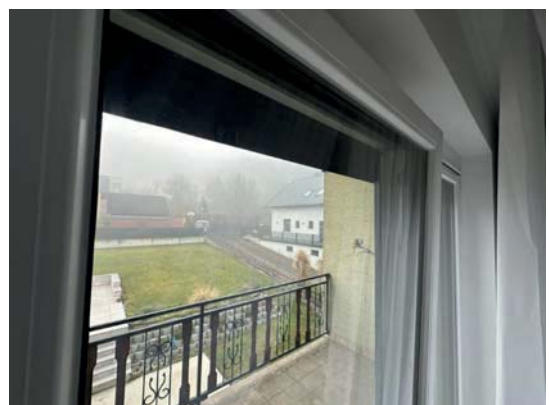
Bild 72 – Schlafzimmer Fenster Richtung Balkon
