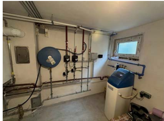
Bild 38 – rechts Wasseraufbereitungsanlage
