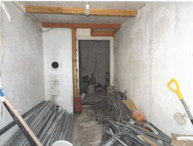
in Natur verbunden mit Bereich der geplanten Garage
