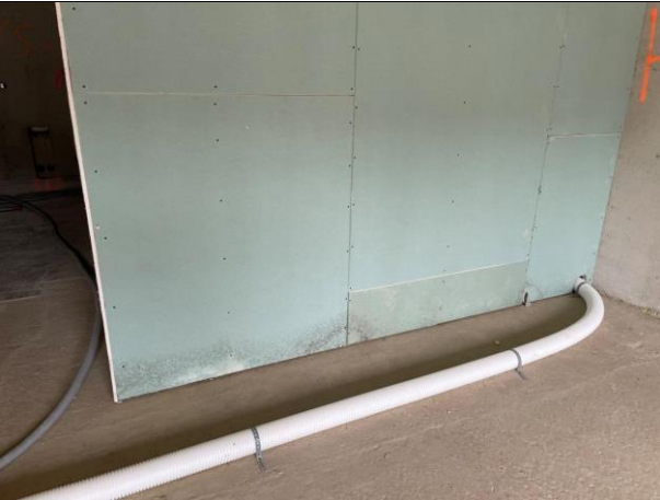
Abbildung 189: Bsph. Feuchteschäden
