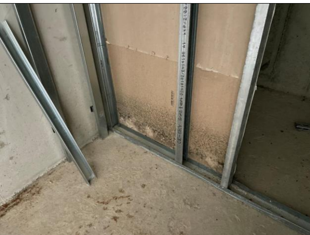
Abbildung 191: Bsph. Feuchteschäden
