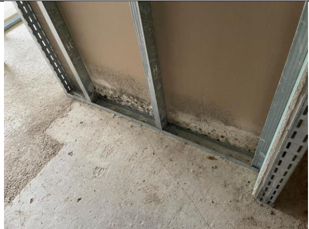
Abbildung 190: Bsph. Feuchteschäden
