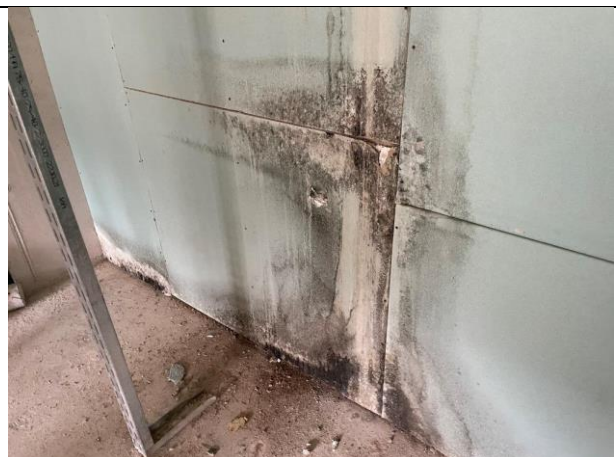
Abbildung 192: Bsph. Feuchteschäden
