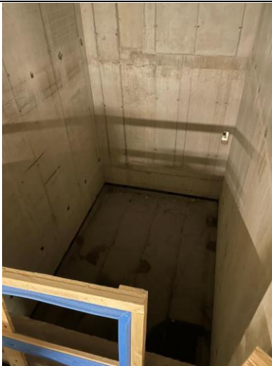
Abbildung 153: Autoaufzugschacht UG 1
