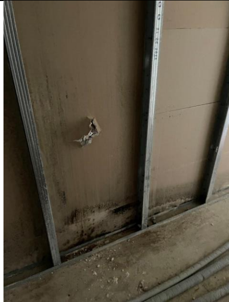
Abbildung 188: Bsph. Feuchteschäden
