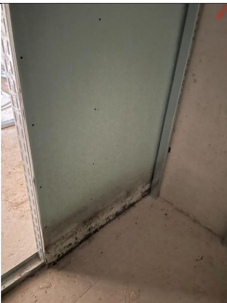
Abbildung 185: Bsph. Feuchteschäden
