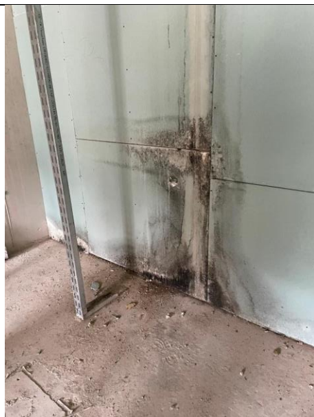
Abbildung 186: Bsph. Feuchteschäden
