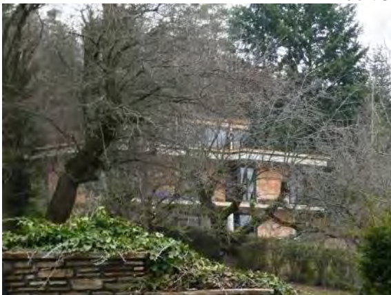
Ansicht West- und Südseite
