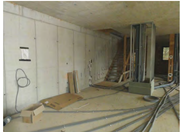
EG Bereich Wohnküche in Richtung Stiege und Foyer
