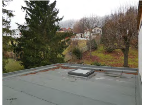
DG begehbares Flachdach in Richtung Nordwesten
