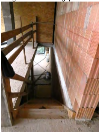
OG provisorischer Stiegenaufgang in das DG
