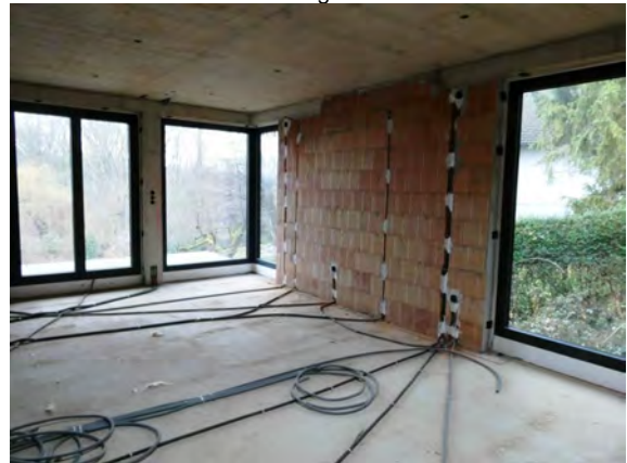
OG Bereich über geplantem Luftraum und Schlafzimmer in Richtung Südwesten
