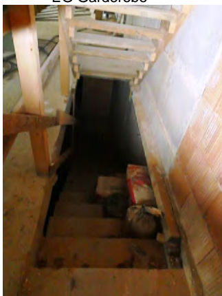
Abgang Keller über Betonstiege
