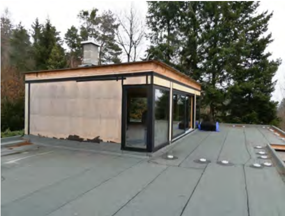
DG mit südseitiger Terrasse und begehbarem Flachdach
