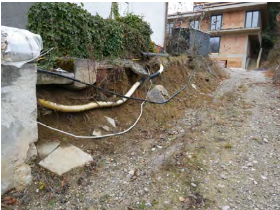
Zufahrtssituation weiter oben, links fehlt noch die Stützmauer
