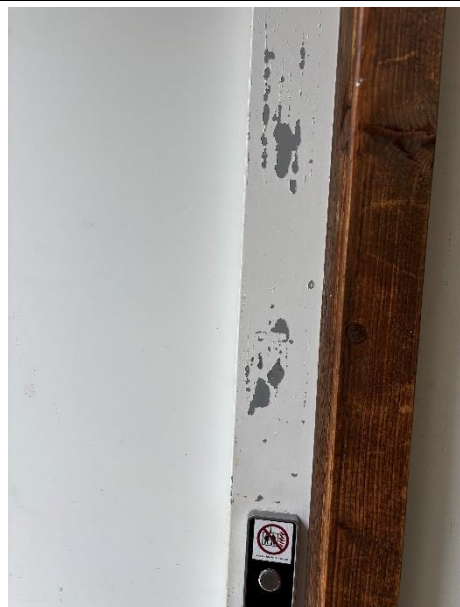
Abbildung 28: Abnutzungen am Aufzug
