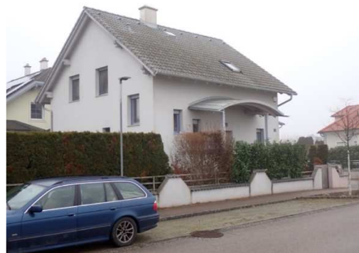
Nord- und Ostfassade
