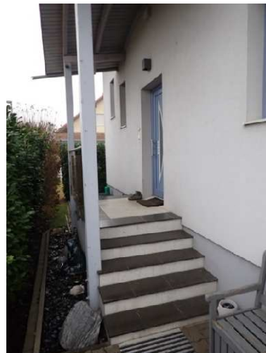
Aufgang in das Erdgeschoß
