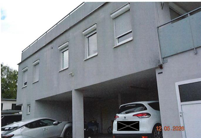
links Abstellraum zu Top 7
