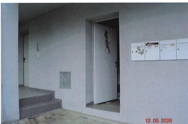
derzeit genutzter Abstellraum
