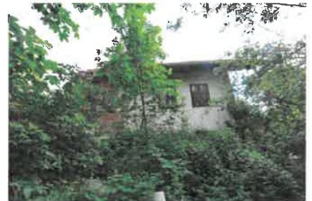
Wohnhaus Brunn 23 / teilweise eingestürzt
