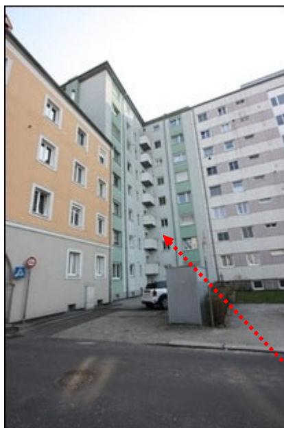
Abb.6 Ansicht Detail zu Abb.5, Wohngeb. Linke Brückenstr. 11 Eckgebäude, links/rechts: Nachbarliegenschaften/-gebäude
