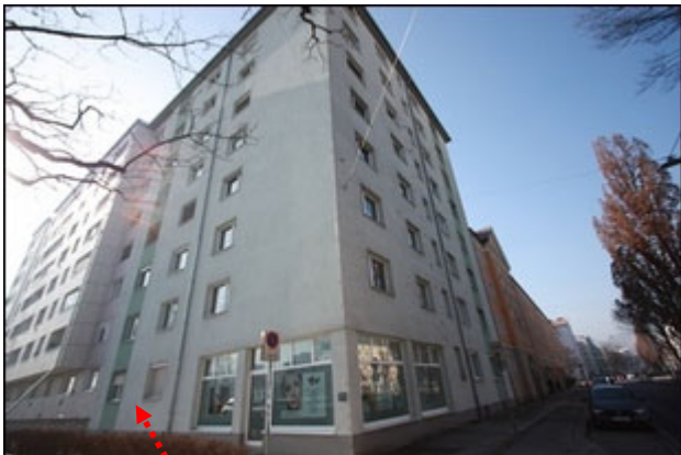
Abb.1 Ansicht Liegenschaft/Wohngebäude Linke Brückenstr. 11 Eckgebäude, Süd- bzw. Straßenseite; links: Nachbargebäude, Lage Wohnung W 1 im EG
