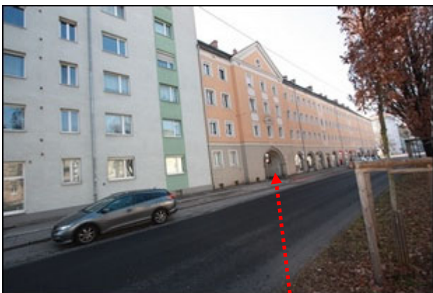
Abb.3 Ansicht Erschließung von/zur Linke Brückenstraße (via Nachbarliegenschaft/-gebäude)
