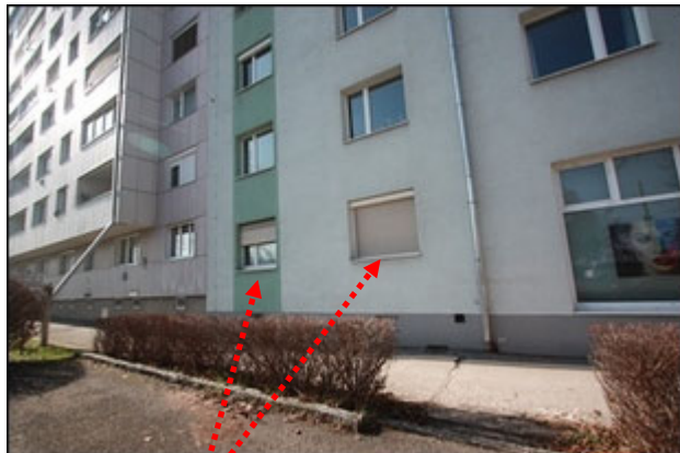
Abb.2 Ansicht Detail zu Abb.1 Lage Wohnung W 1 im EG (2 Fenster an der Südostseite)
