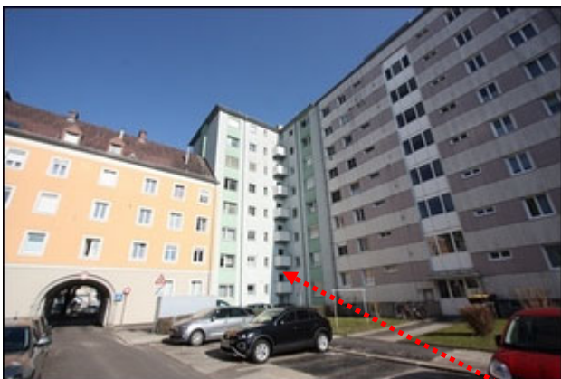
Abb.5 Ansicht Liegenschaft/Wohngebäude Linke Brückenstr. 11, Eckgebäude, links/rechts: Nachbarliegenschaften/-gebäude
