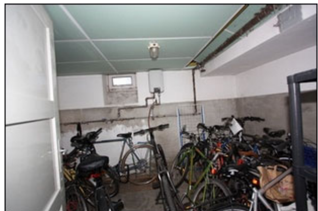
Abb.38 Ansicht ehem. Waschküche (Fahrrad-/Lagerraum)
