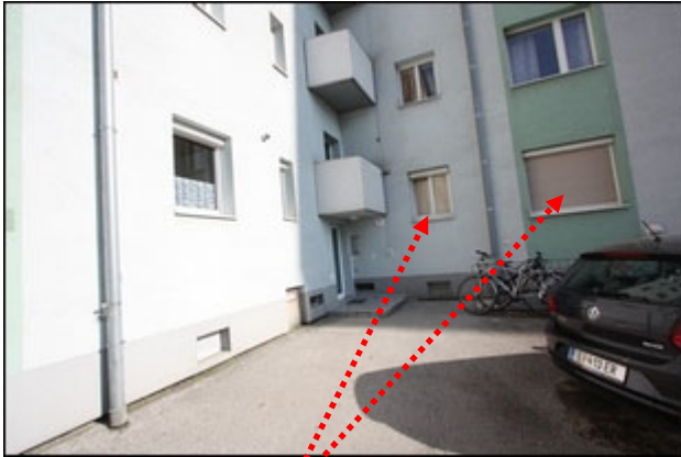
Abb.7 Ansicht Detail zu Abb.6, Zugang Linke Brückenstr. 11 Wohnung W 1 im EG (2 Fenster an der Nordwestseite)
