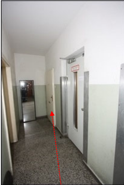
Abb.13 Ansicht EG, Flur Zugang zur Wohnung W1 und Lift
