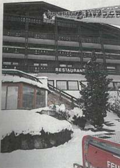
Aufstellpunkt Parkplatz Garmischer Straße
