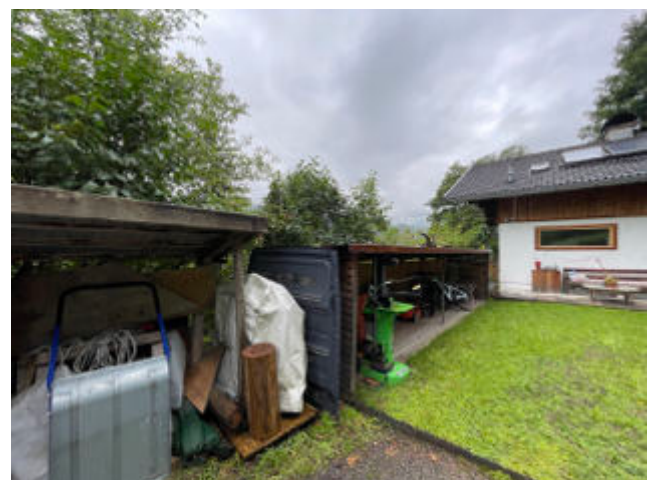
Nebengebäude Ost 2.jpeg
