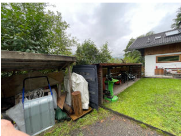
Nebengebäude Ost 1.jpeg
