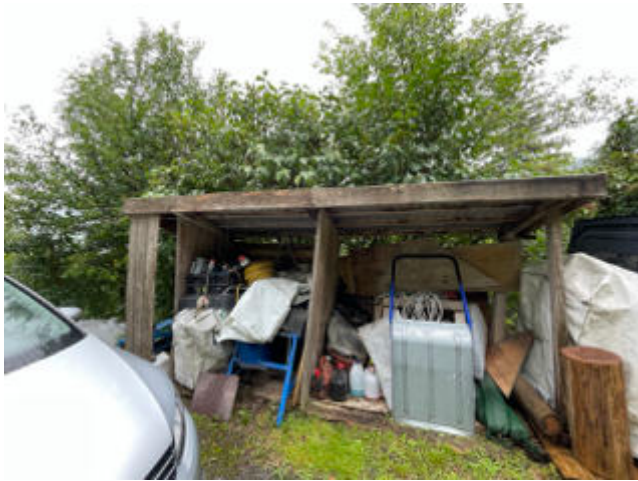
Nebengebäude Ost 3.jpeg
