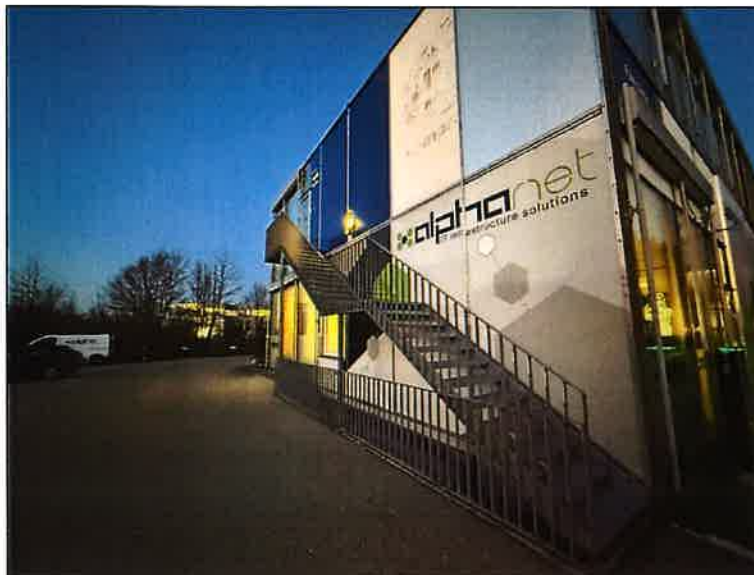
über Außeneisenstiege in den 1. Stock
