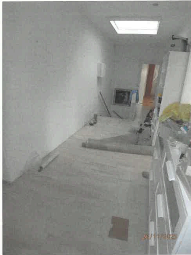
Vorraum mit Stiegenhaus
