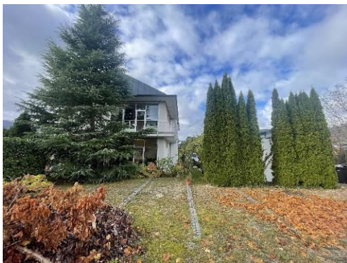
Ostansicht Büro- und Wohngebäude
