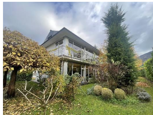
Südwestansicht Büro- und Wohngebäude
