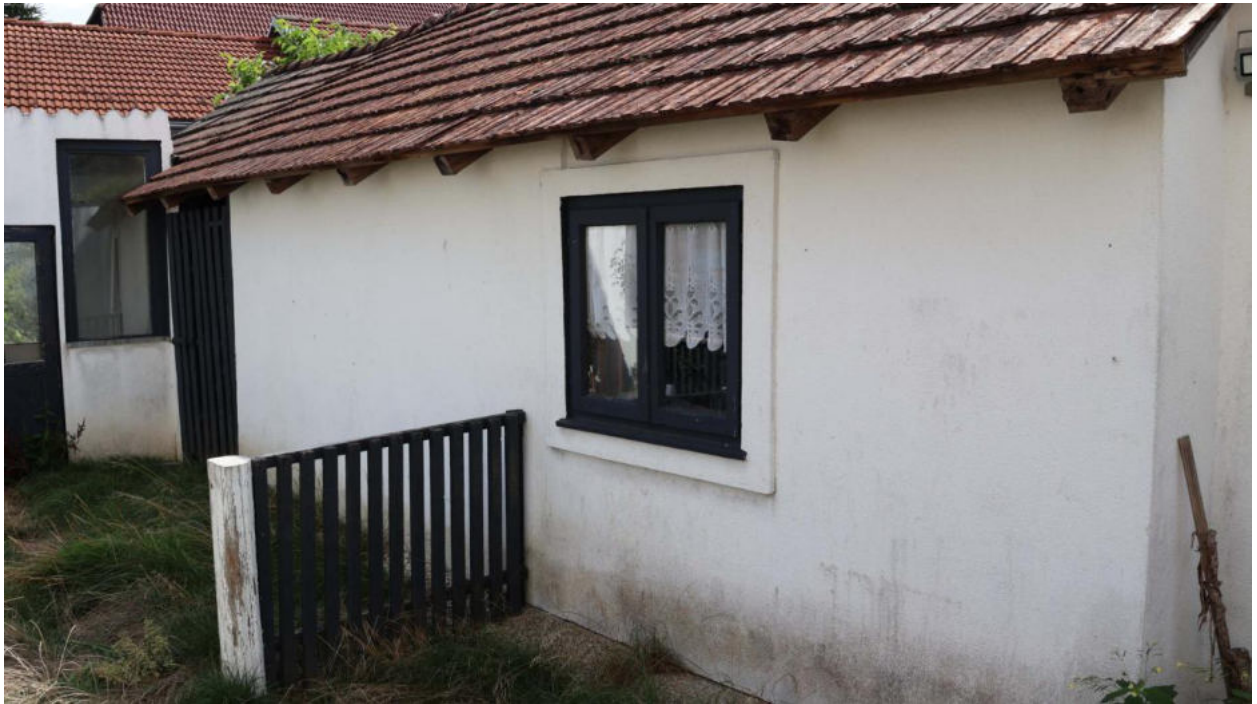
Bild 63 Teilweise ausgebautes Nebengebäude C an der Südseite
