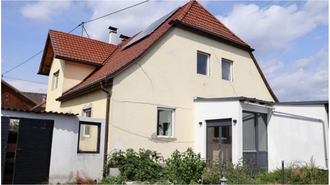
Bild 5 Gebäudeansicht von der Südostseite
