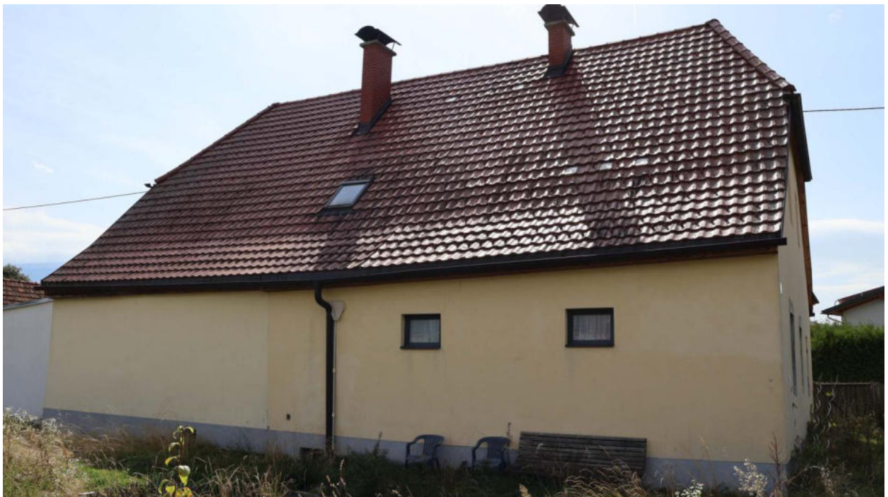
Bild 2 Gebäudeansicht von der Nordseite
