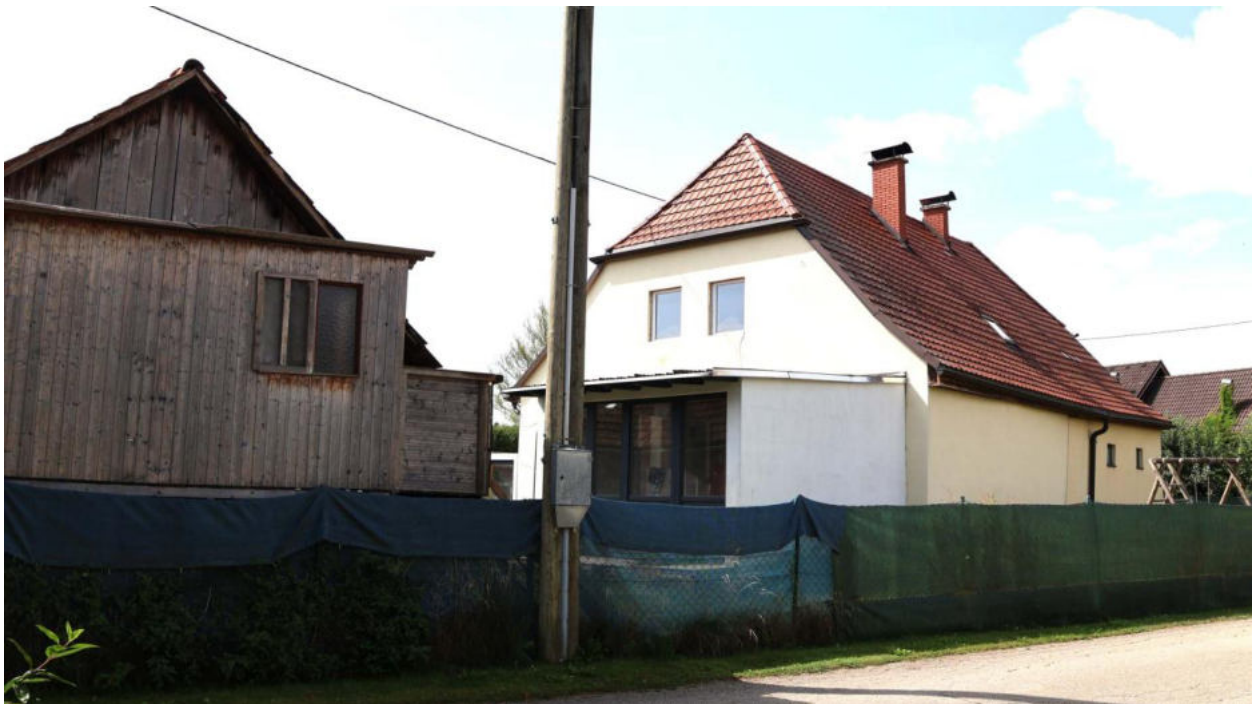
Bild 18 Wohnhaus und Nebengebäude Ansicht Nordostseite
