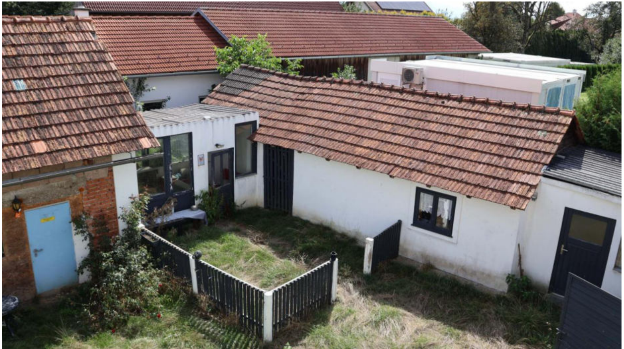
Bild 11 Nebengebäude C – Ansicht von der Nordwestseite mit Zwischentrakt B
