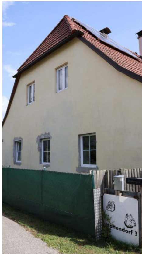
Bild 20 Wohnhaus Westfassade mit PV-Anlage
