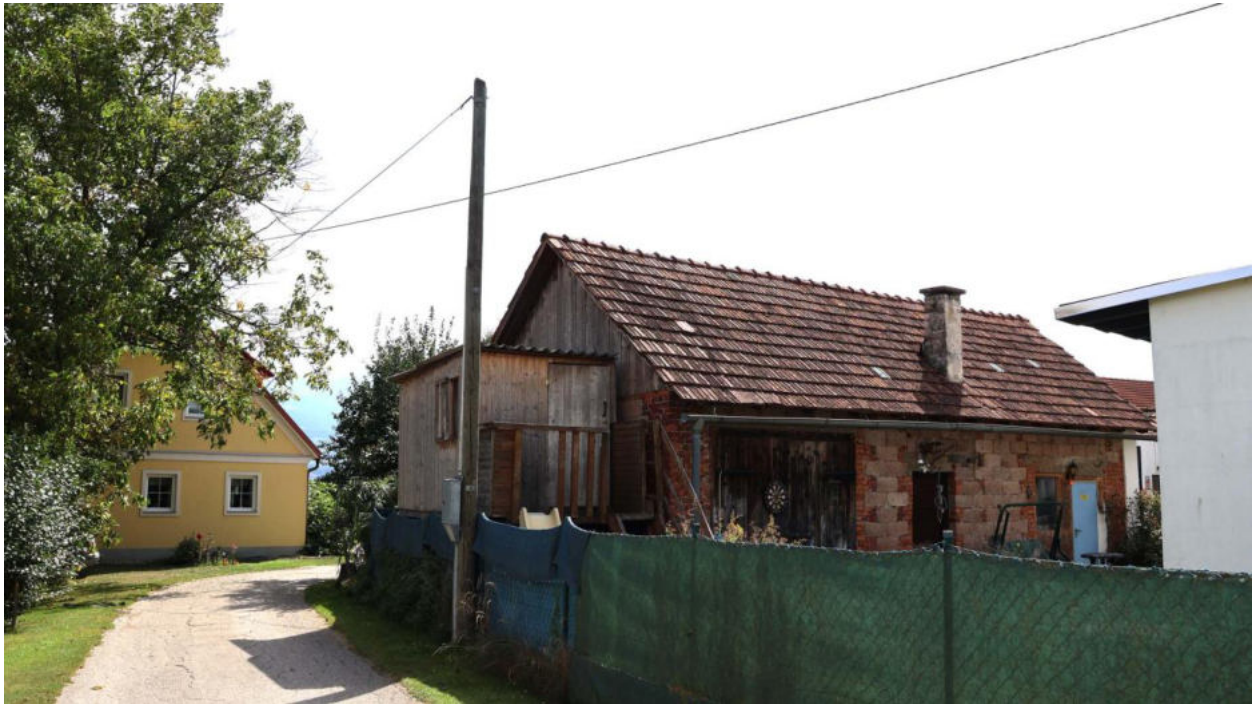
Bild 13 Nebengebäude Ansicht Nordwest
