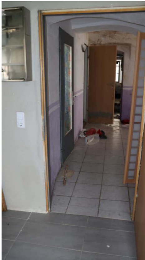
Bild 38 Zugangstüre EG Badezimmer mit Flur
