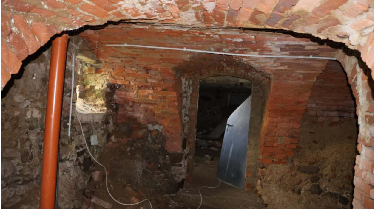
Bild 61 Kellergewölbe mit beschädigter Kellertüre
