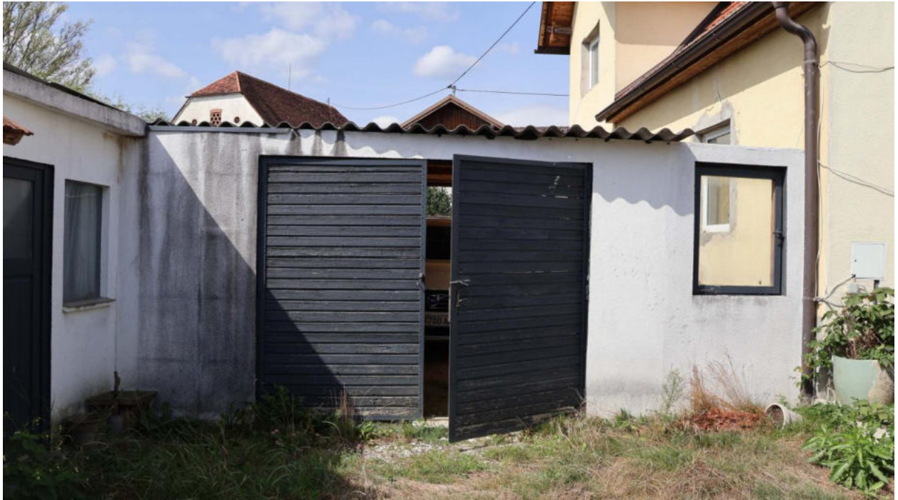
Bild 9 Trennwand zum Innenhof vom Carport
