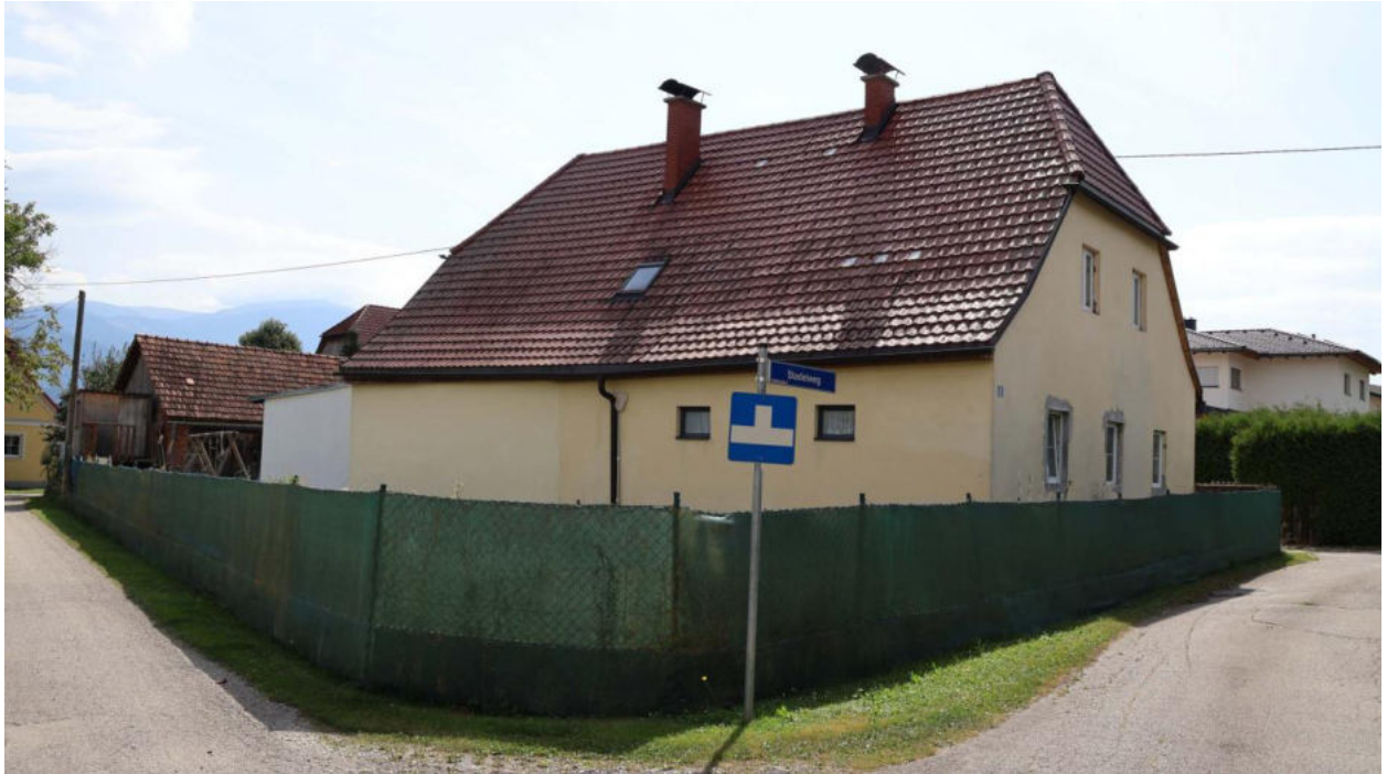
Bild 3 Gebäudeansicht von der Nordwestseite
