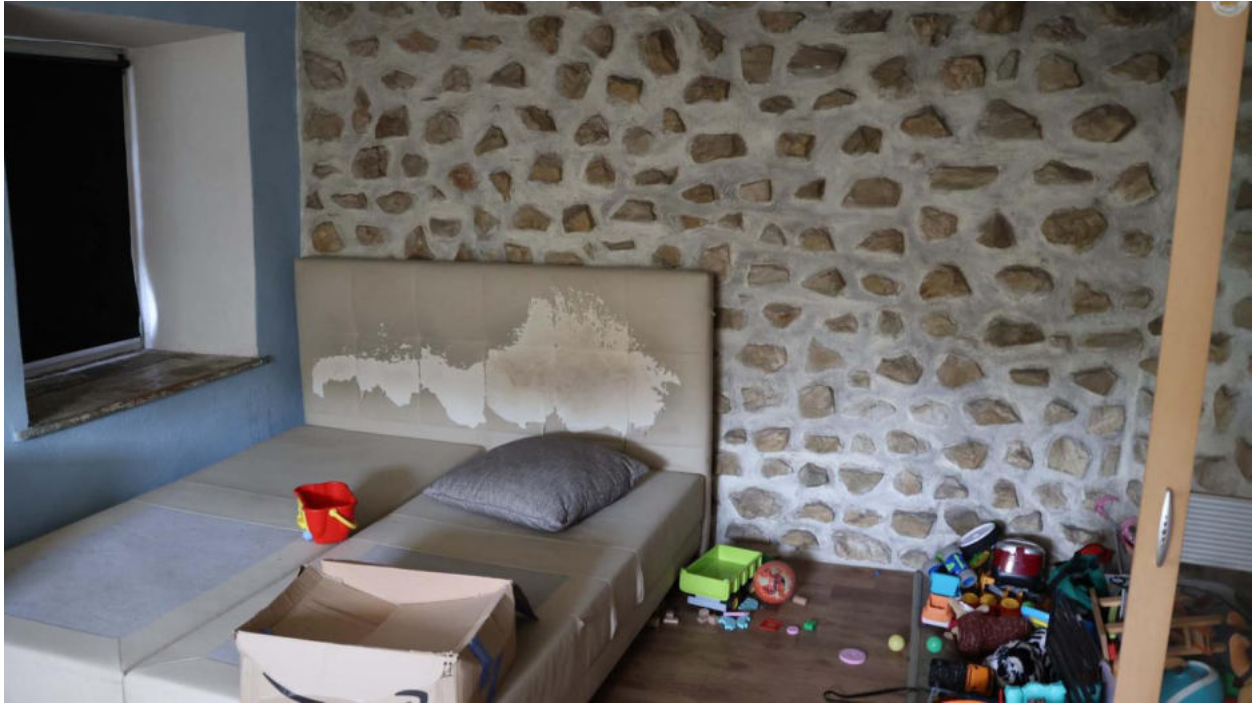
Bild 27 EG Kinderzimmer Südwest
