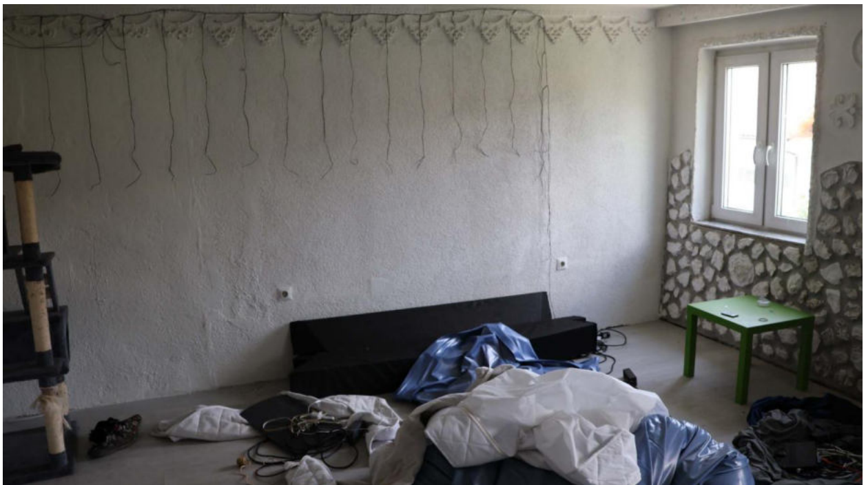
Bild 48 DG Zimmer West
