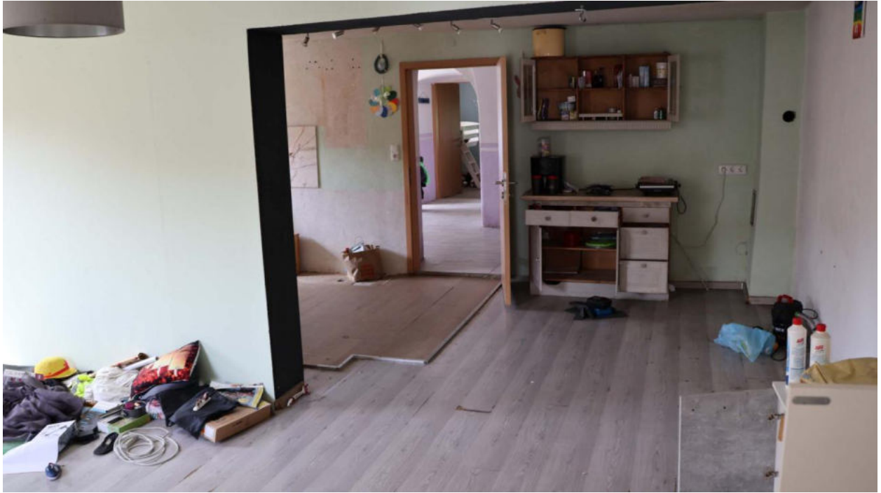
Bild 21 EG Wohnhaus Küche
