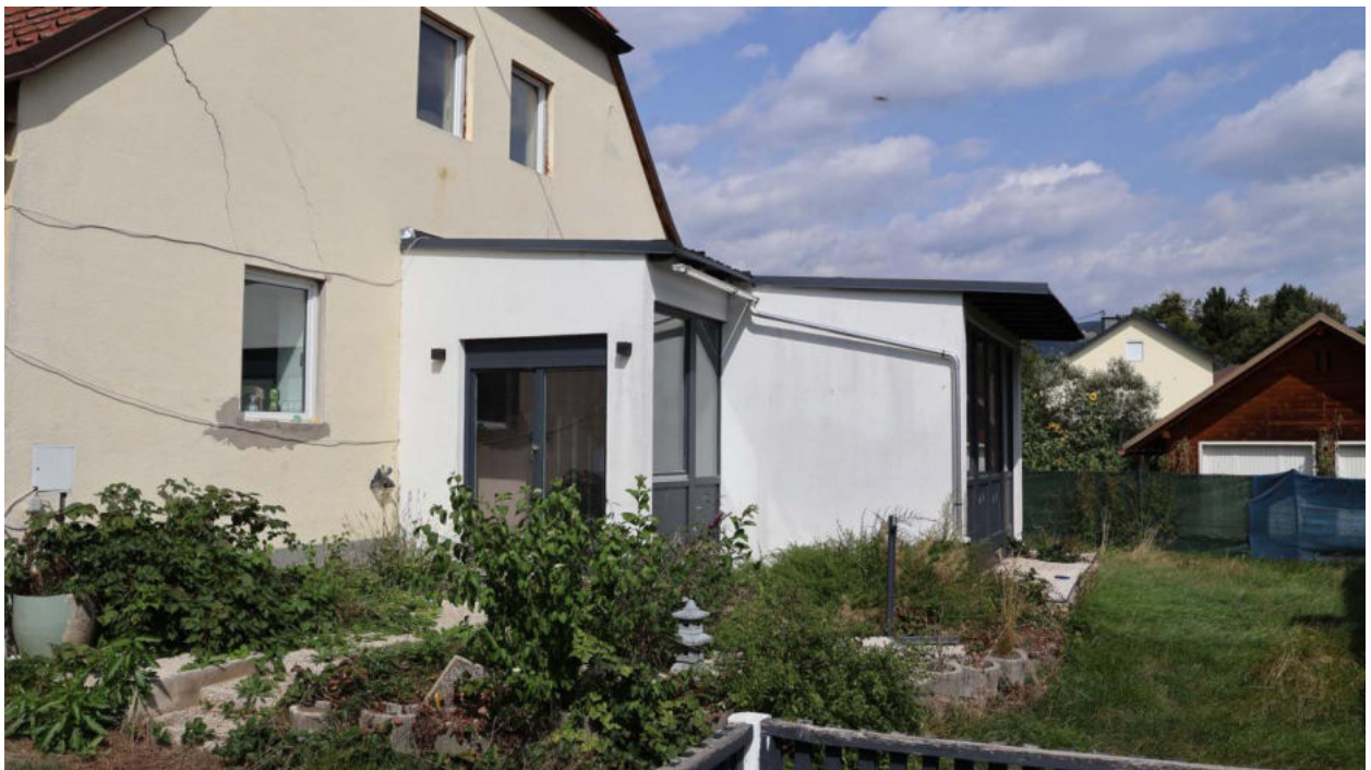
Bild 4 Wintergartenanbau an der Ostseite
