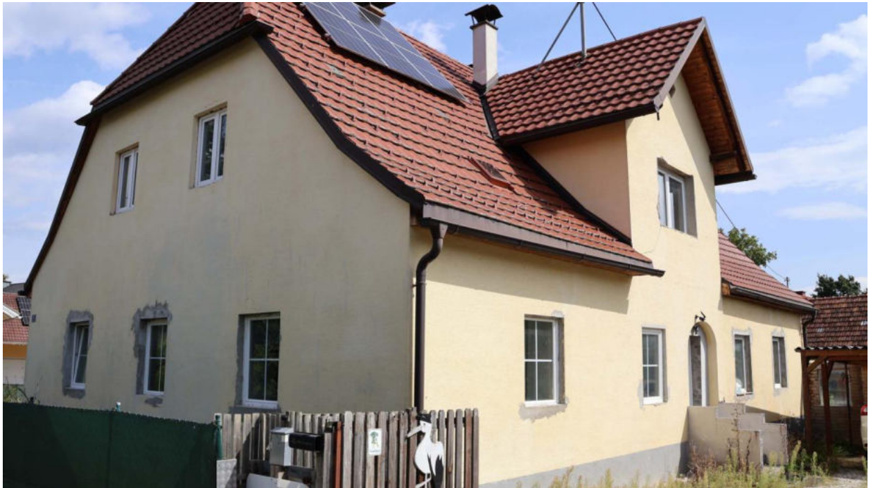
Bild 1 Gebäudeansicht von der Südwestseite
