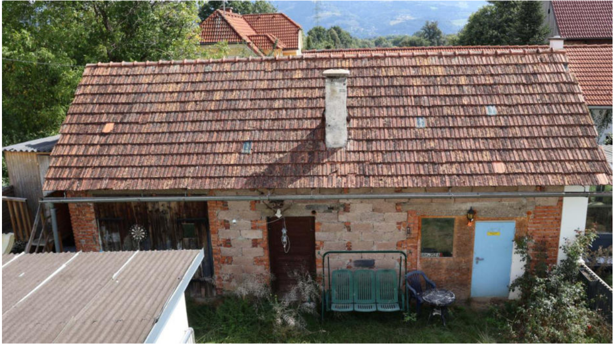
Bild 19 Dachausbildung Nebengebäude A und Wintergarten
