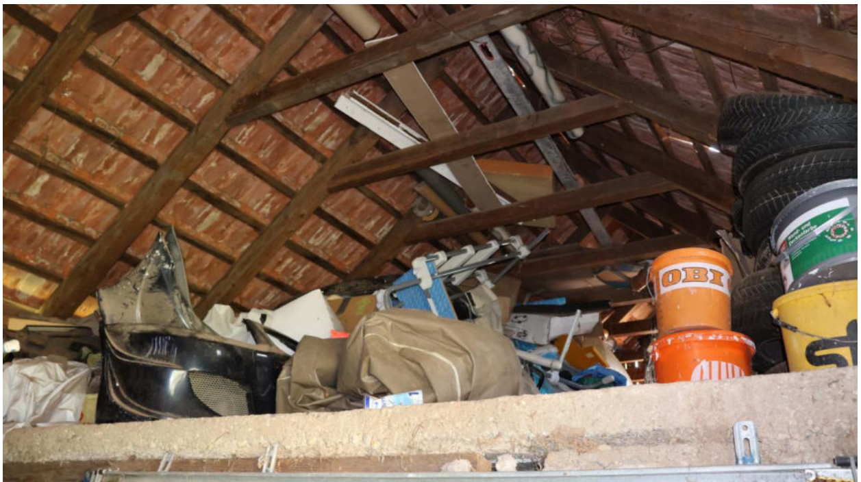
Bild 70 Nebengebäude A - Dachboden
