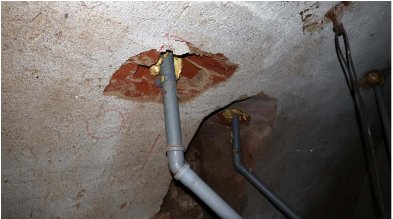
Bild 60 Abflussleitungen im Kellergewölbe
