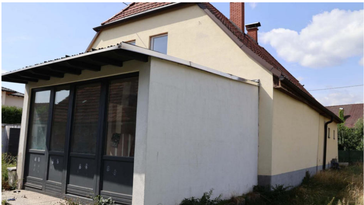
Gebäudeansicht von der Nordostecke mit Wintergartenanbau
