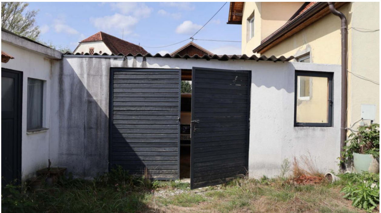
Trennwand mit Zufahrtstor zum Carport zwischen Wohnhaus und Nebengebäude
