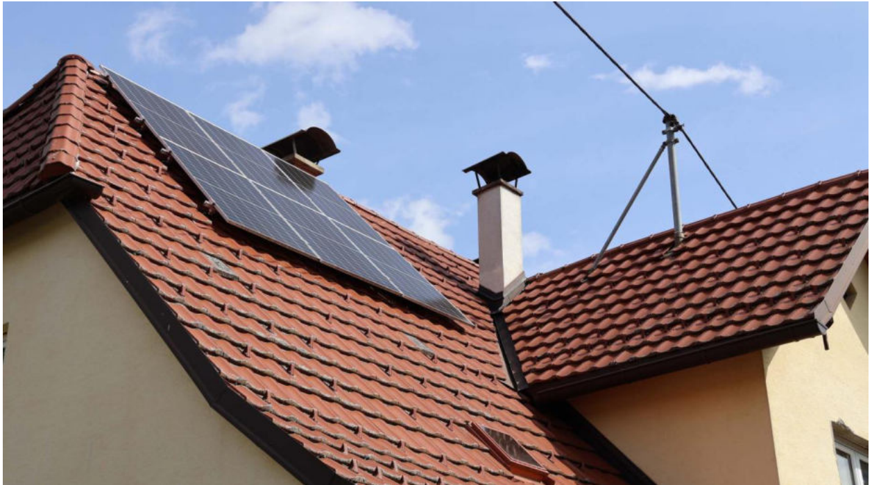
Strommast als Dachständer am Wohnhausgiebel, daneben PV-Anlage Westseite
