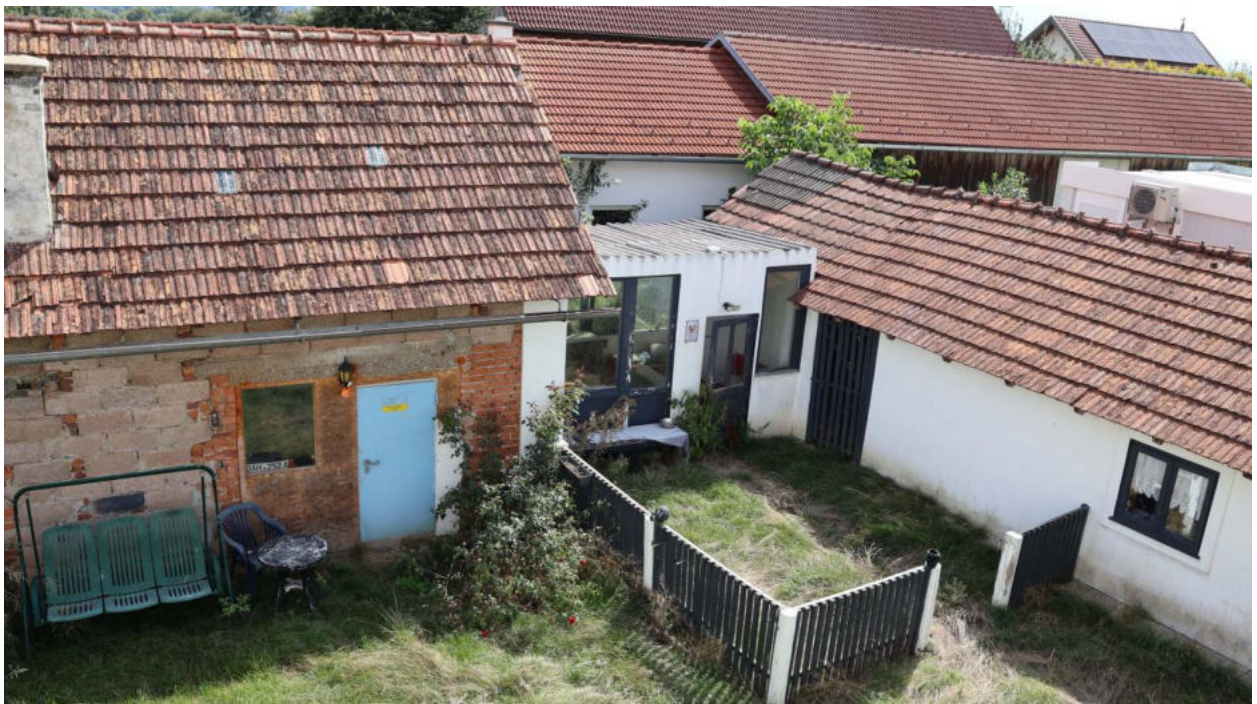
Nebengebäude mit Zwischentrakt im südöstlichen Grundstückseck
