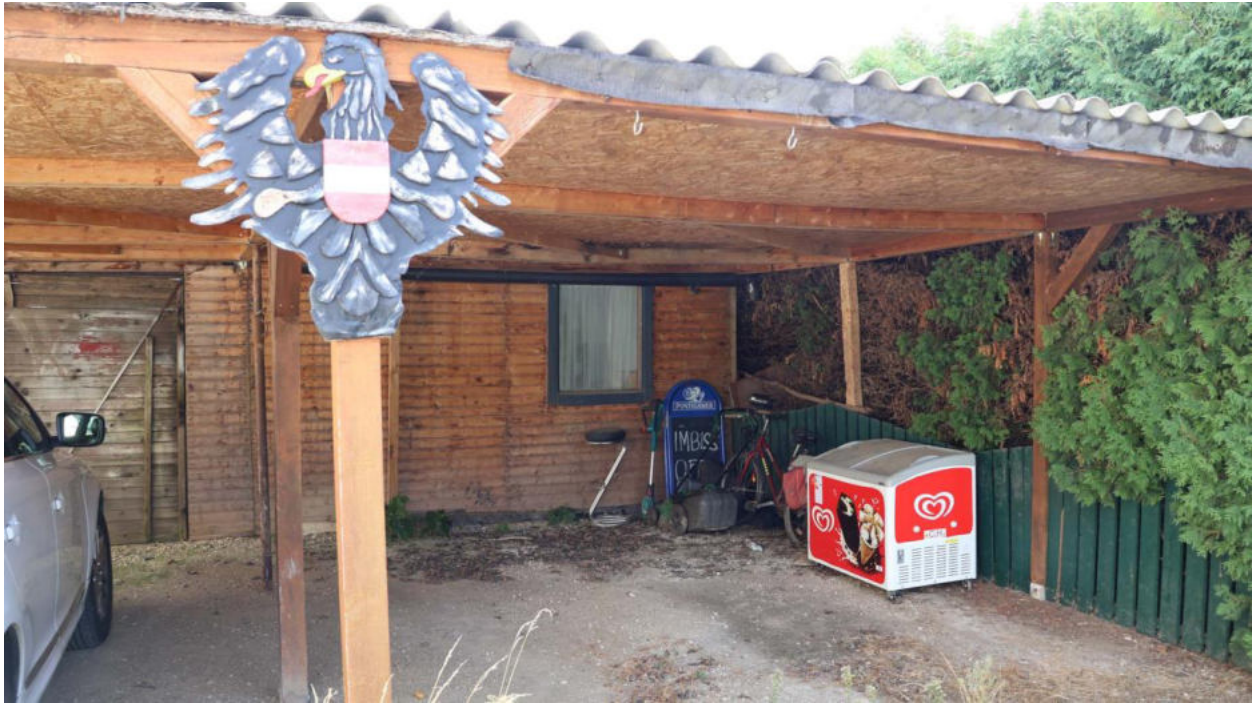
„Filigranes“ Carport mit Thujenhecke entlang der Südseite
