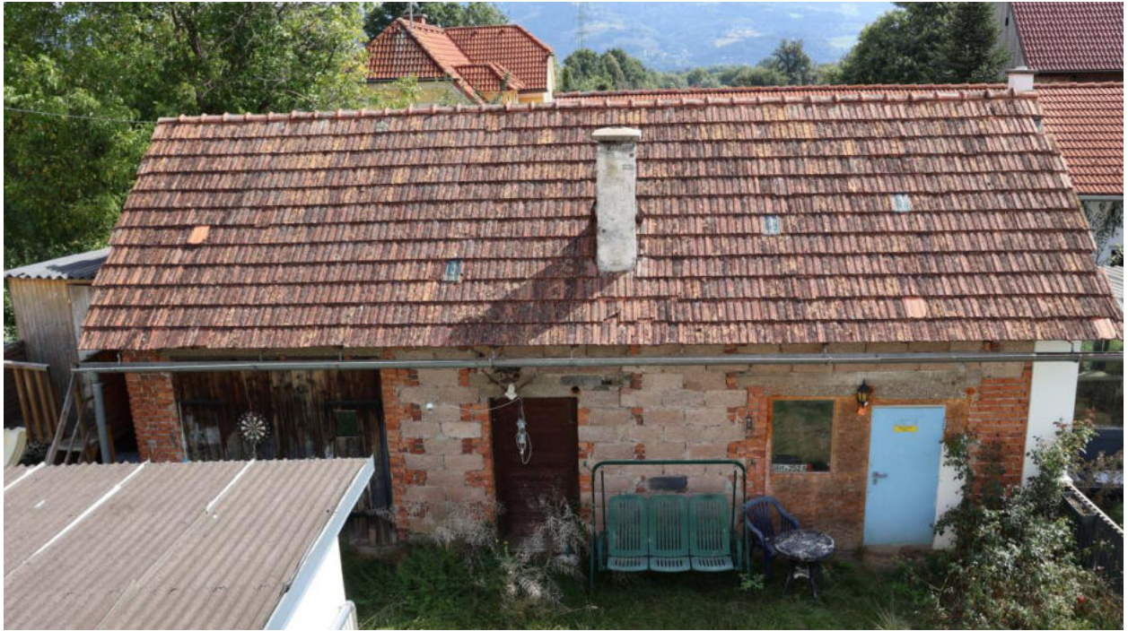
Nebengebäude A – Hofansicht Westseite
