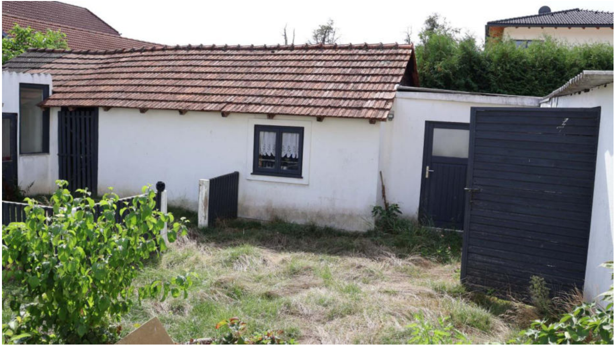
Nebengebäude C – Ansicht Nordseite vom Innenhof
