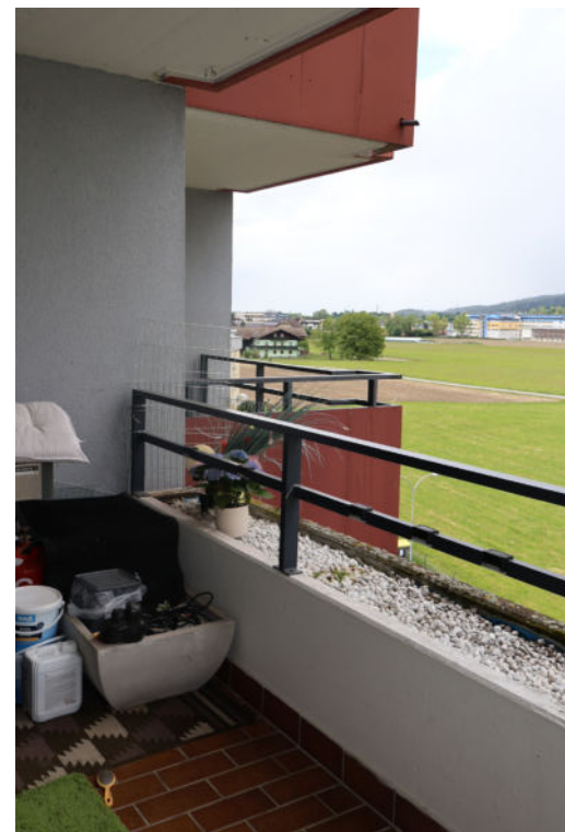
Balkon W 22 Haus 2
