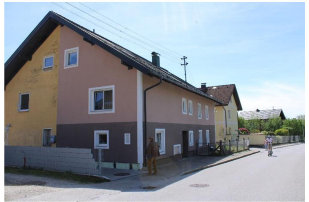
Ansicht Wohnhaus (rechte Hälfte) von Norden
