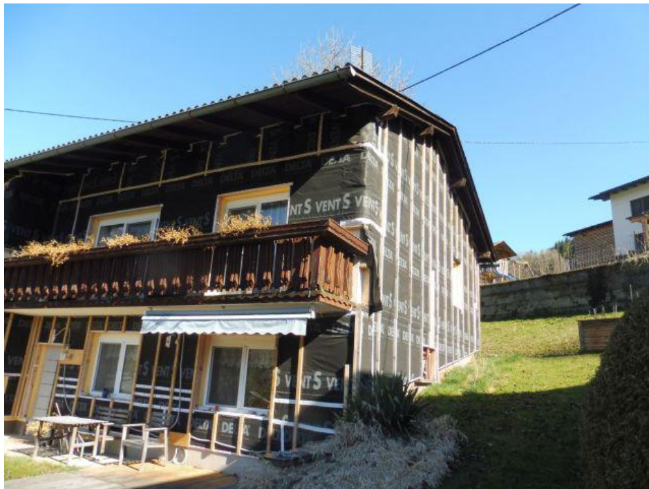
Teilansicht Südseite und Ostseite (oben)
