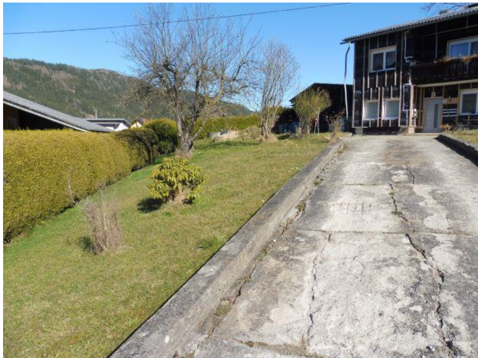
Teilansicht Südseite und südwestliche Grundstücksbereich (unten)
