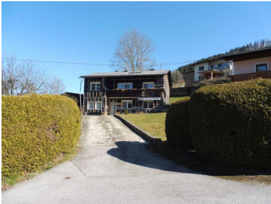
Ansicht aus Süden mit Einfahrtsbereich (oben)
