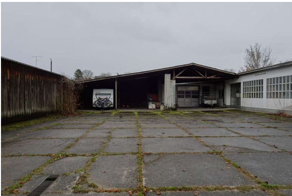
Halle Ost – Flugdach - Halle West
