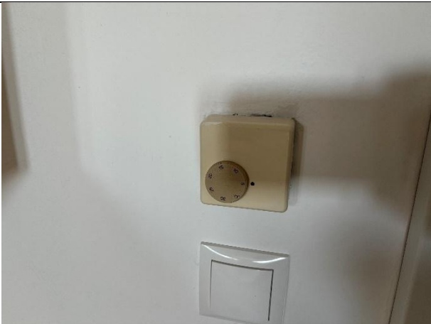
Abbildung 64: Heizungsregler
