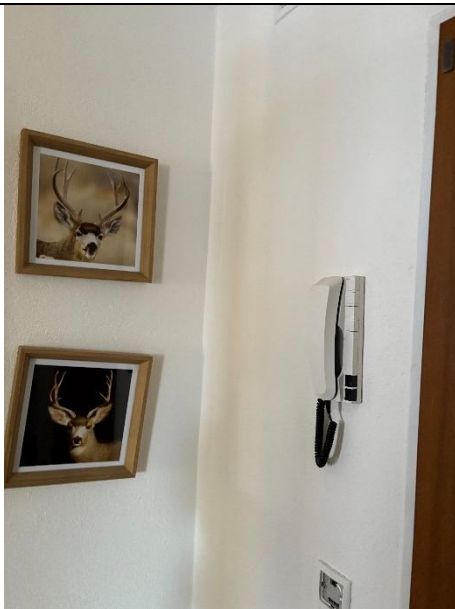
Abbildung 66: Gegensprechanlage
