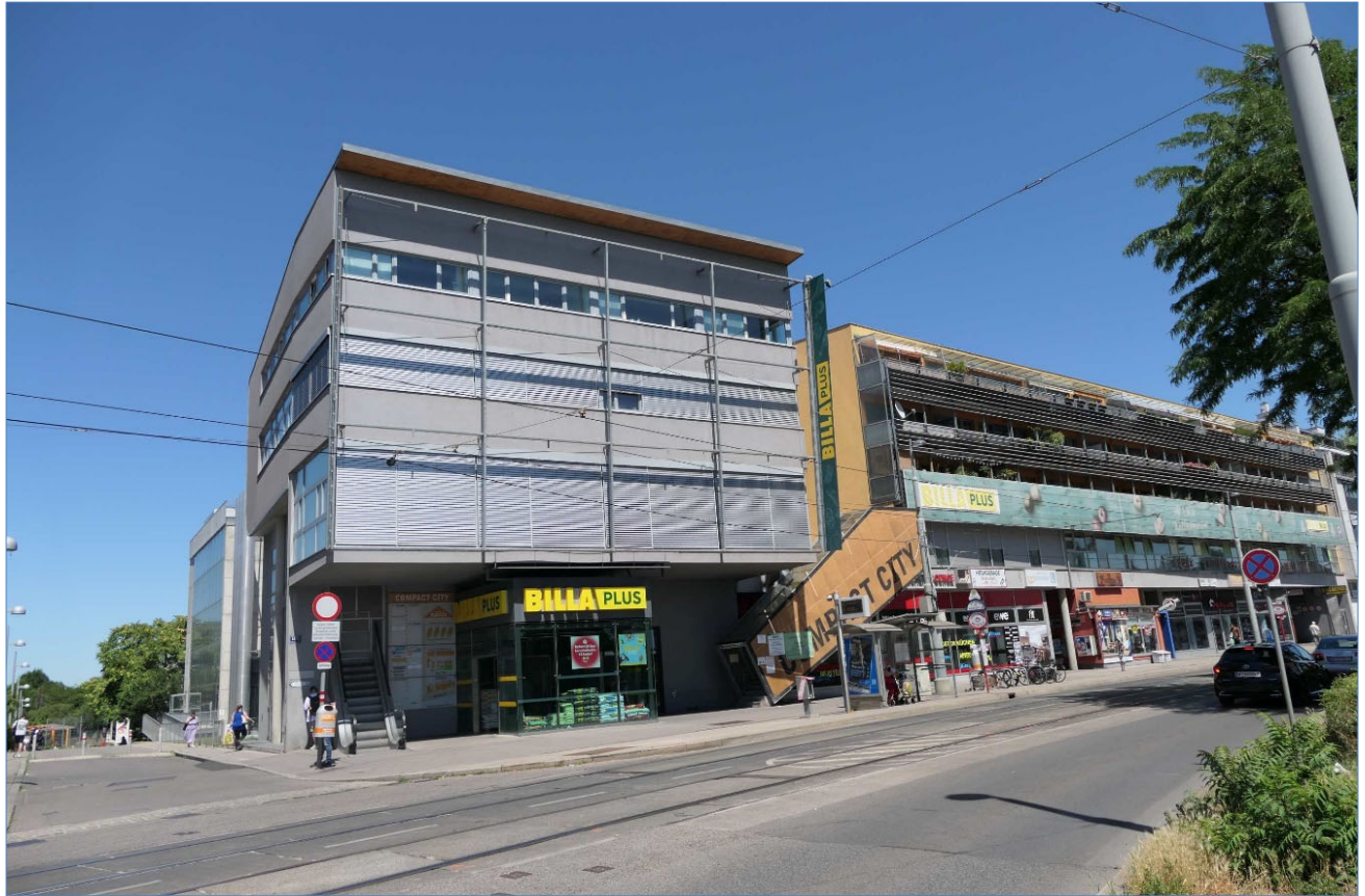
Ansicht Donaufelder Straße
